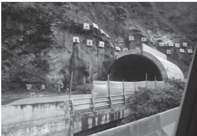
工事中のトンネル
