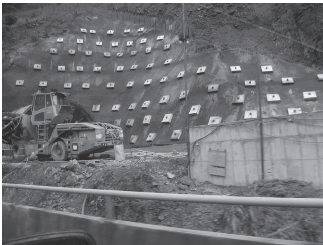
対面通行におけるトンネル工事
