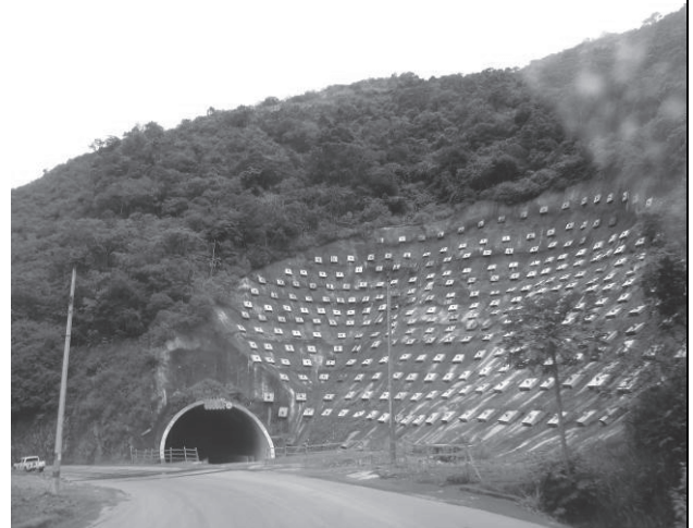
トンネル工事と坑口付近の大規模な斜面安定工
