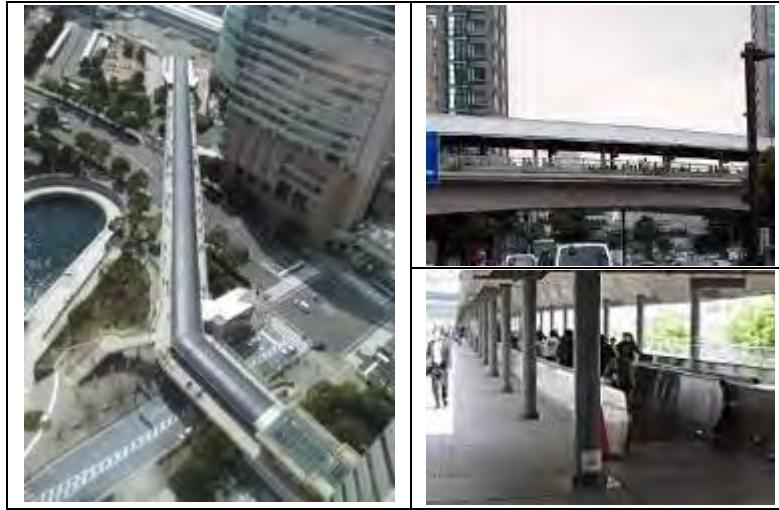
Hình 3.2.12 Cầu bộ hành với lối đi bộ di động (Ga Sakuragi-cho, Yokohama)
