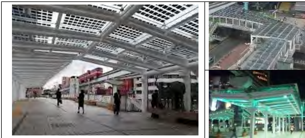
Hình 3.2.13 Cầu bộ hành với đèn chiếu và tấm pin năng lượng mặt trời (Ga Kokura, TP. Kitakyushuu)
