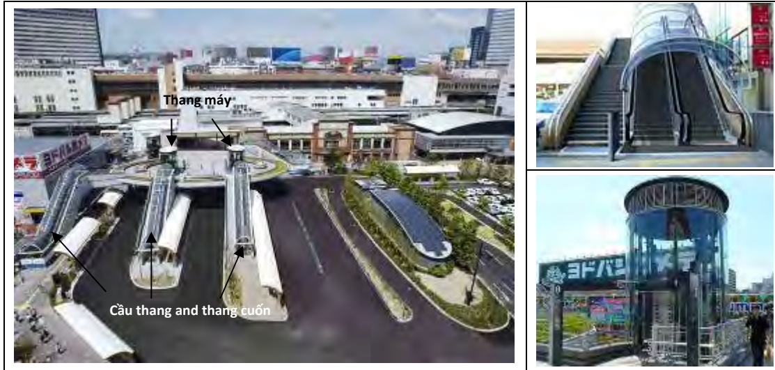
Hình 3.2.10 Cầu bộ hành có Thang cuốn và Thang máy (Ga JR Sendai)
