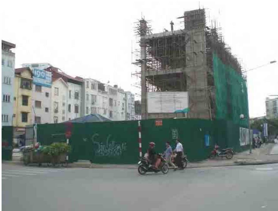
図 3.5 Kim Ma BRT Terminal の建設風景
