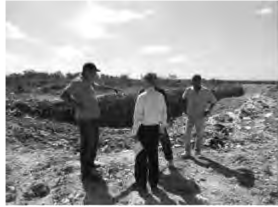
Reexcavación de la forma de trinchera
