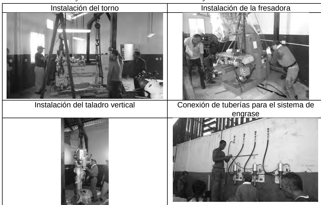
Foto 5-6: Instalación de equipos y el trabajo de tuberías
