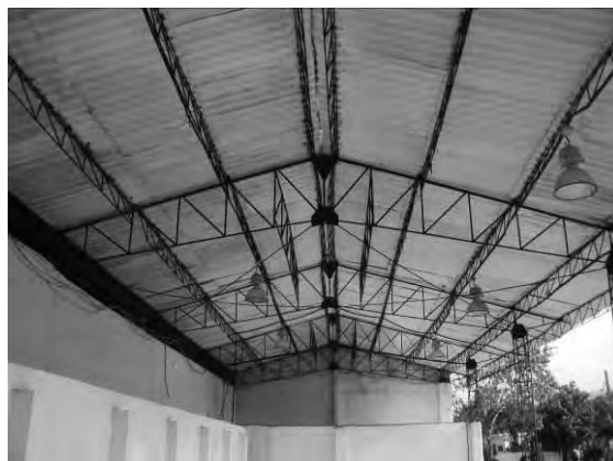
Foto 1-12: Instalación del techo (14 de Febrero, 2012)
