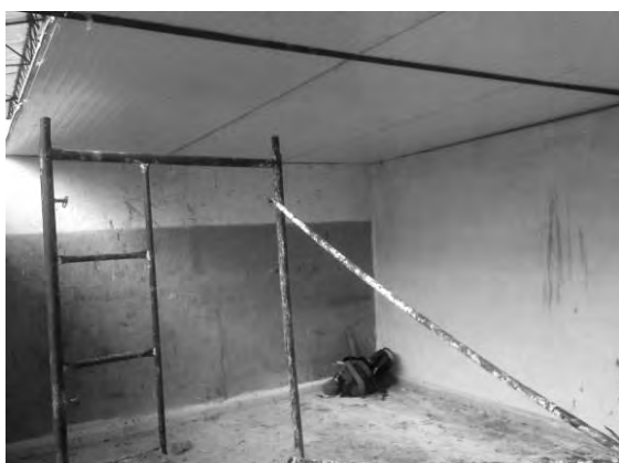
Foto 1-9: Obra de la oficina-sala de capacitación (7 de Febrero, 2012)
