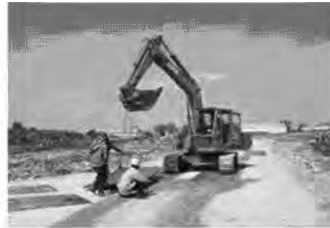
Construcción de la carretera principal
