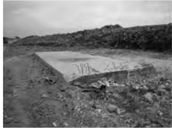
Foto 3-19: Base de concreto para la báscula, Ocho Vías
