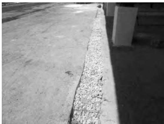
Foto 1-24: Drenaje con grava
