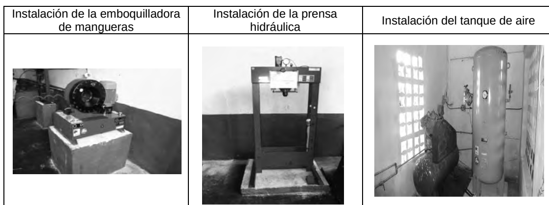
Foto 7-4: Instalación de Emboquilladora, Prensa Hidráulica, y Tanque de Aire
