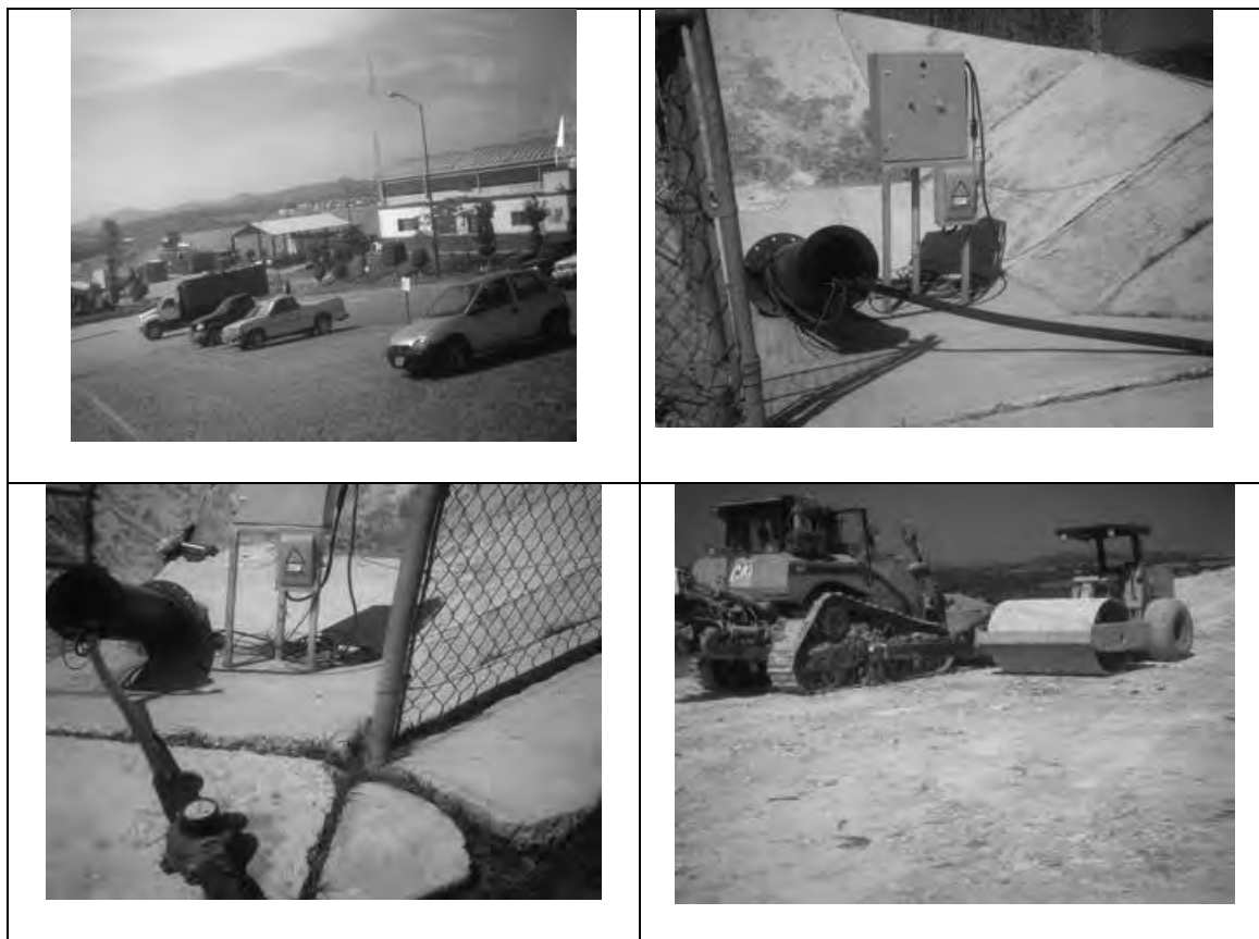
Foto 1-6: Facilidades de Relleno Sanitario de Puebla.
