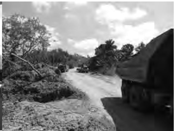
Foto 7-9: Escenarios de los preparativos de obra
