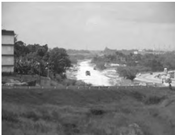
Foto 6-9: Vía férrea en construcción
