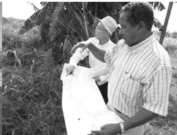
Foto 6-10: Confirmación del lugar de construcción del nuevo acceso vial
