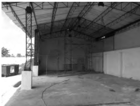
Foto 1-11: Instalación de las rejillas para la separación del área de la trituradora (17 de Febrero, 2012)
