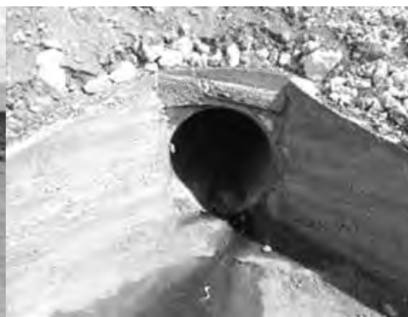
Foto 7-7: Situación de ejecución de conducto de cruce
