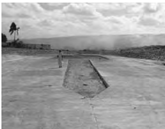
Foto 7-6: Cerca de bascula del nuevo vía de acceso
