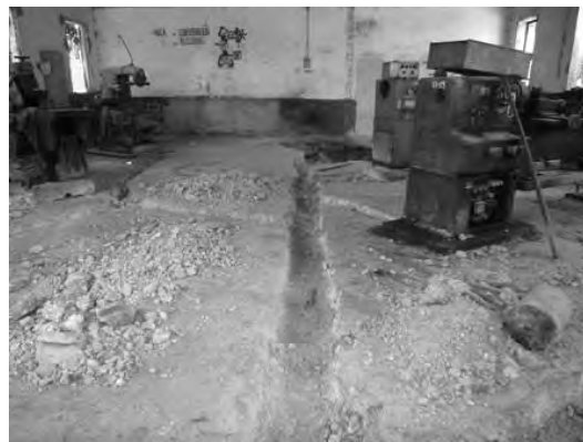
Después de la ampliación de las zanjas, 28 de febrero
