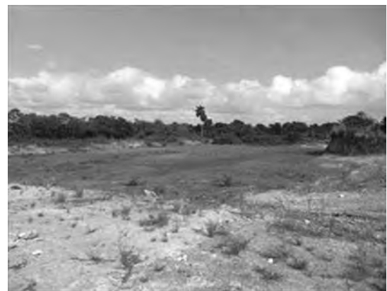
Foto 6-21: Vista general de la laguna de oxidación
