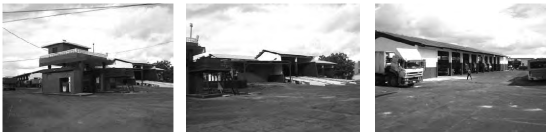
Foto 5-1: Reparación del taller Central por parte Cubana
