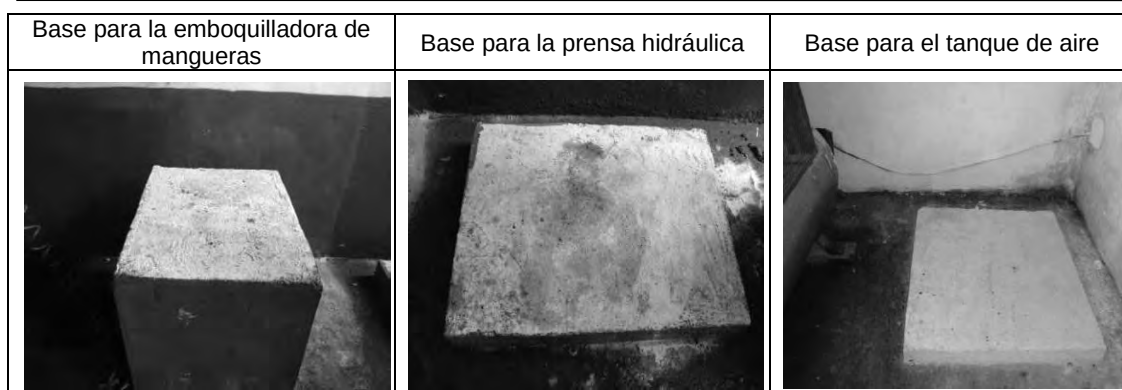
Foto 7-3: Base para Emboquilladora, Prensa Hidráulica, y Tanque de Aire
