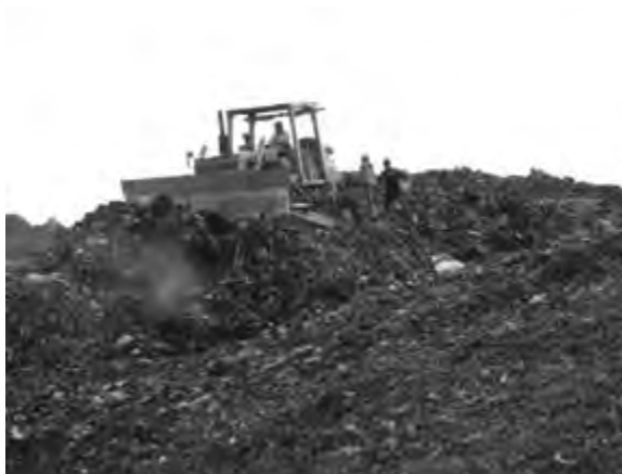
Foto 7-2: Operación de extinción
