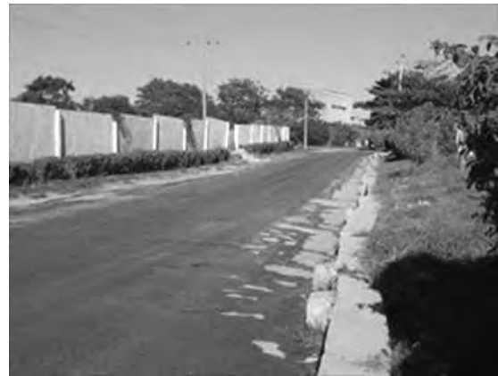
Foto 6-2: Vía de acceso rociada
