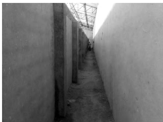
Foto 1-10: Construcción del muro de deslinde con el almacén del Taller Central (lado izquierdo) (11 de Febrero, 2012)
