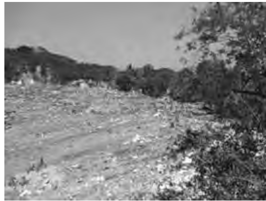
Situación de relleno
