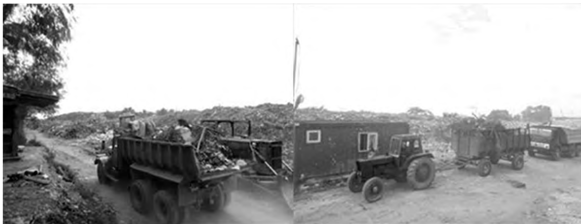
写真 6-5 : トラックスケール基礎付近
