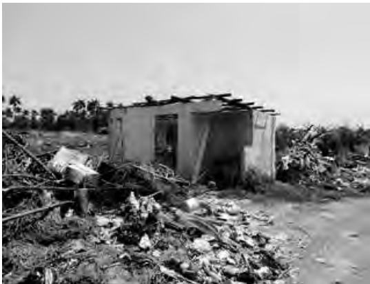
壊された管理小屋と入口付近にダンプされたごみ
