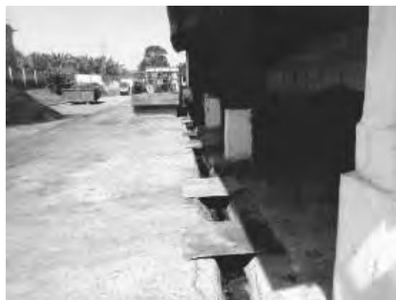
写真 1-25 : 改善した排水溝
