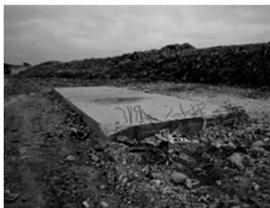
オチョビアスのトラックスケール基礎部
