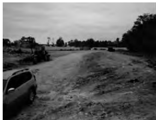
写真 3-11 : 入口付近拡幅後 (オチョビ アス)
