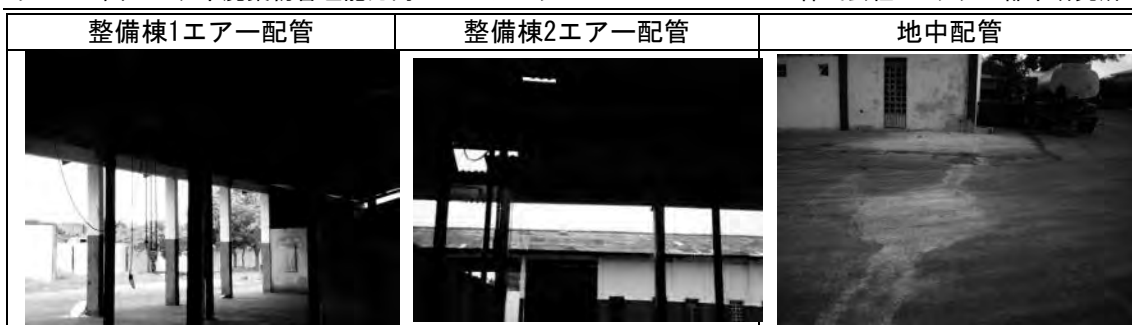
写真 7-8: 整備棟1及び整備棟2
