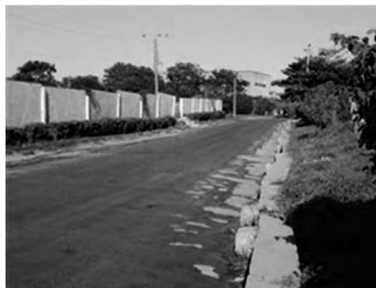
写真 6-2：散水した搬入道路
