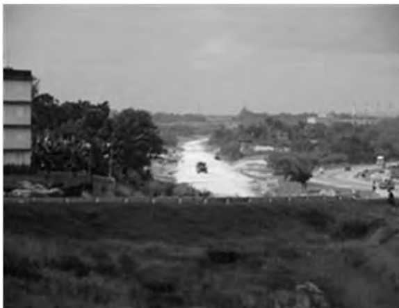
写真 6-9 : 建設中の鉄道線路
