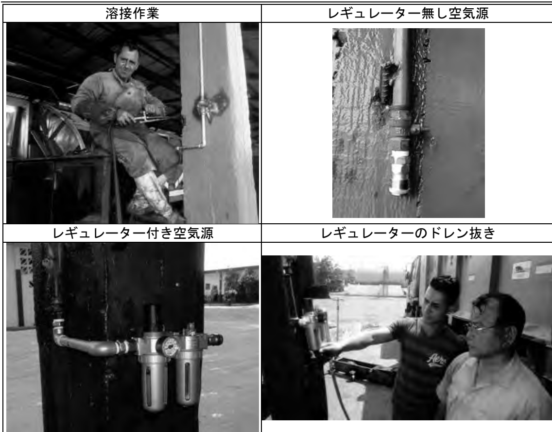
写真 8-2: エア配管工事
