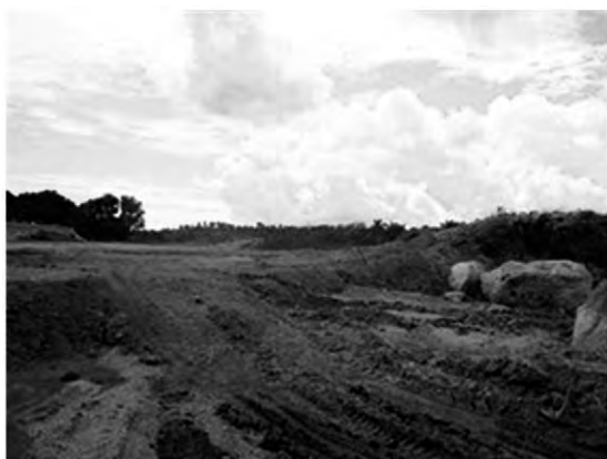
搬入道路基礎部分造成工事（2011年10月）
