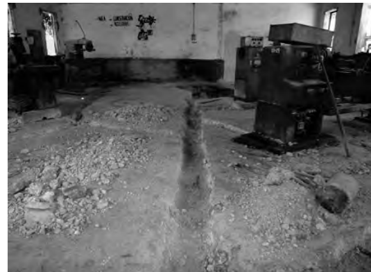
拡大掘削後、2月28日撮影
