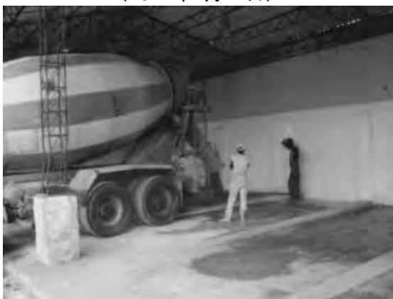
写真 1-5 : 床工事のための生コンの打設 (2012年2月13日)
