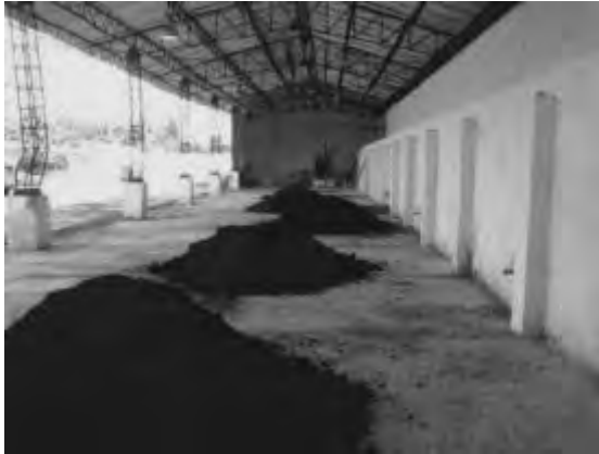
写真 1-13 : 工事完了後のコンポストヤード
