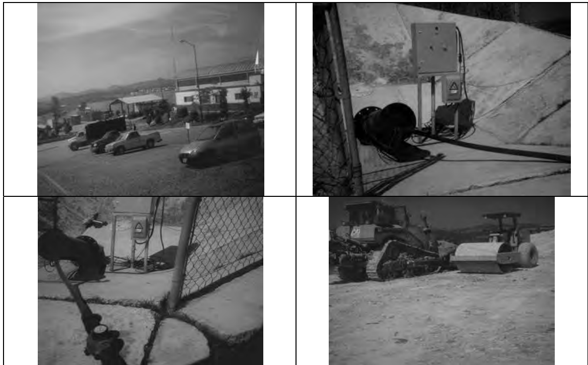
写真 1-6: プエブラ市処分場の施設
