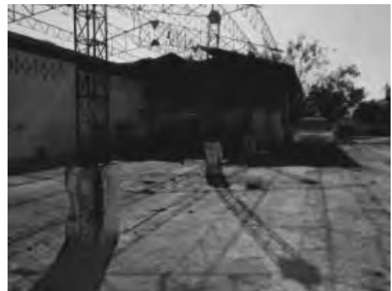
写真 1-4 : 工事前のコンポストヤード (2011年2月17日)
