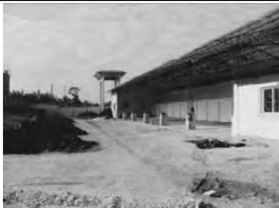
写真 1-7 : 工事のために屋外へ移動したコンポスト (2012年2月14日)
