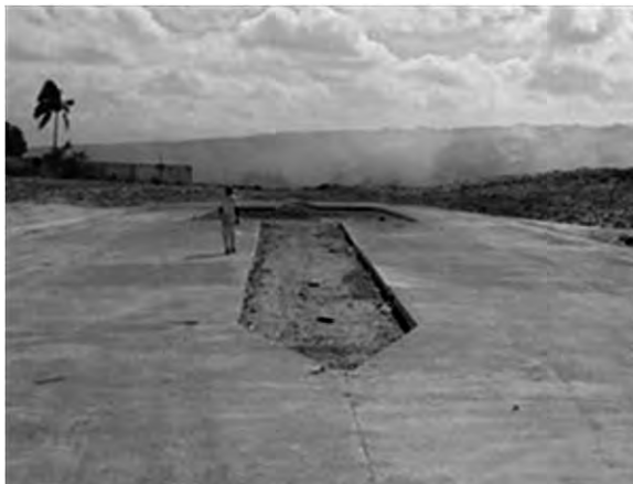
写真 7-4: 新搬入道路トラックスケール付近
