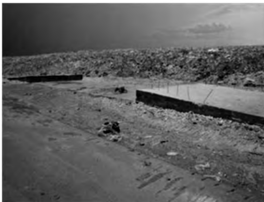
トラックスケール基礎（2011年5月）
