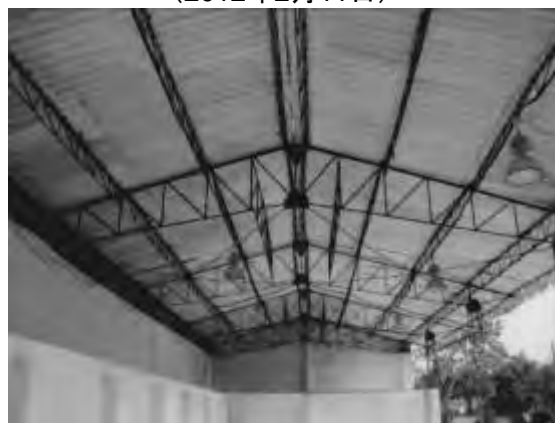
写真 1-12 : 屋根設置工事 (2012年2月14日)
