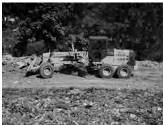
写真 3-10 : 搬入道路拡幅作業 (オチョビ アス)
