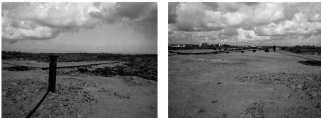
CDM事業によるメタンガス回収井付近の覆土（2011年5月）
