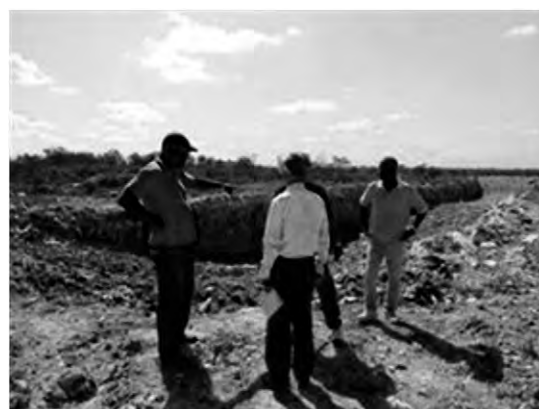
トレンチ状の再掘削の状況
