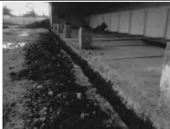
写真 1-8 : 排水溝工事 (2012年2月8日)
