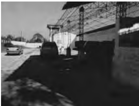
写真 1-3 : 工事前のコンポストヤード (2011年2月17日)
