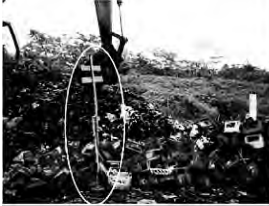
図 3-4 : トンボによる埋立高さの管理
