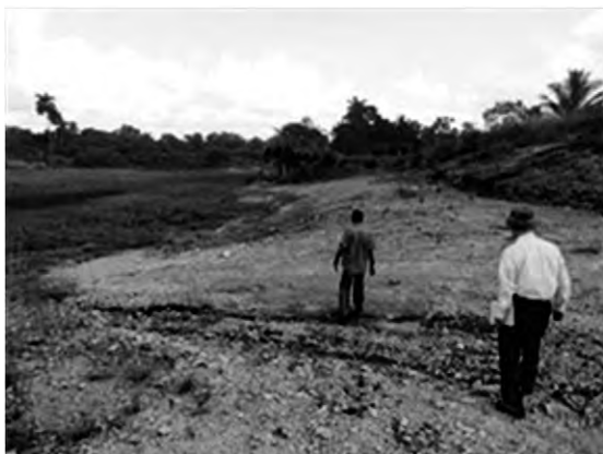
写真 6-20: 酸化池の法面
