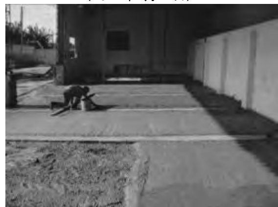
写真 1-6 : 床工事 (2012年2月13日) 2
