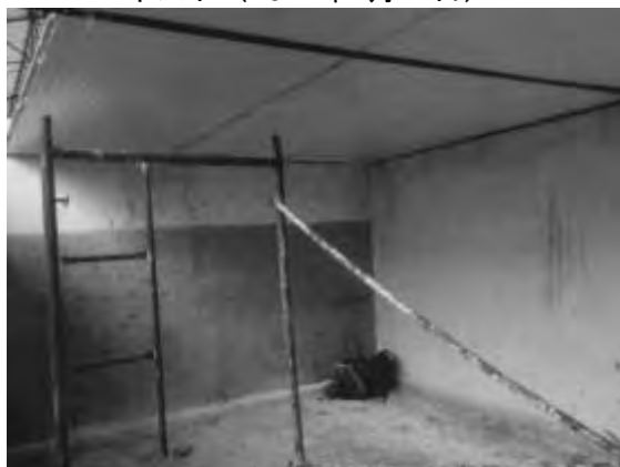
写真 1-9 : 事務室兼セミナー室設置工事 (2012年2月7日)
