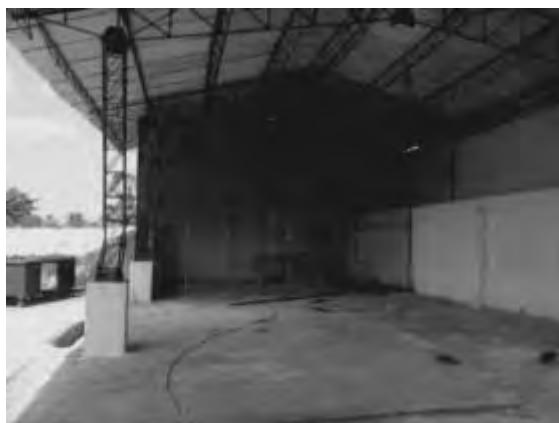
写真 1-11 : 粉砕器置き場仕切網設置工事 (2012年2月17日)
