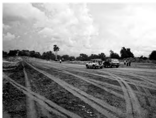
貯留堰堤基礎部分造成工事（2011年10月）
