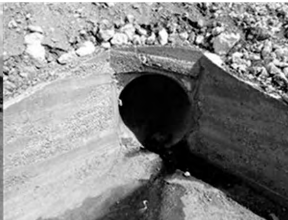
写真 7-5: 横断暗渠の施工状況
