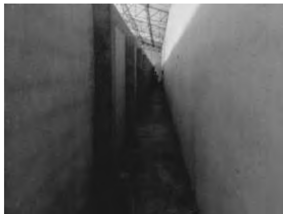
写真 1-10 : 倉庫との仕切壁 (左側) 設置 (2012年2月11日)
