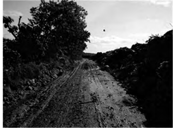
降雨後の搬入道路状況（2011年10月）
