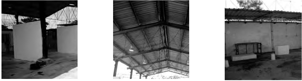
写真 5-8: キューバ側による重機整備場の改善工事
