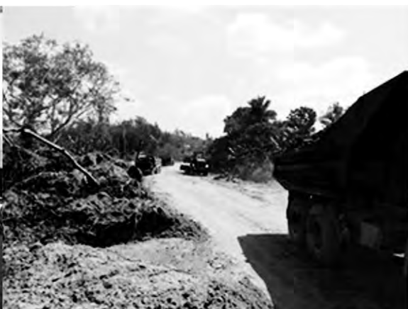
写真 7-7: 準備工事の様子
