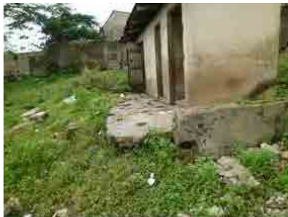
写真： 既存トイレの状況
