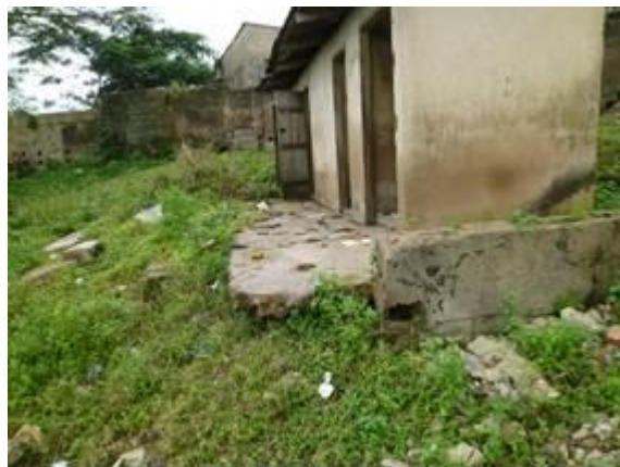
写真： 既存トイレの状況
