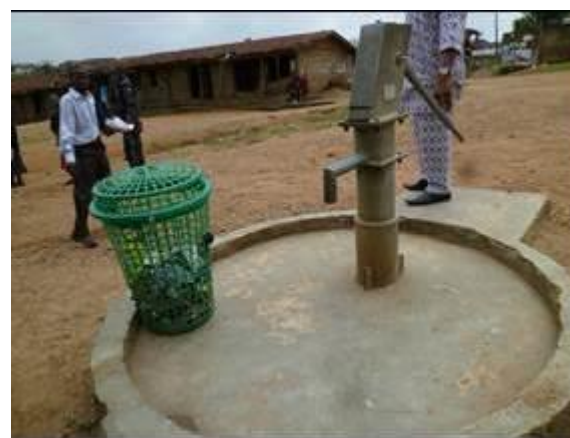
写真： 井戸ハンドポンプ
