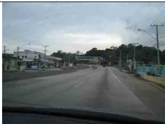
10. 都市エリア。商業関係の建物がパンアメリカン道路沿いにあり、住居もいくつかある。
