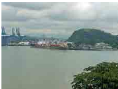
写真7 第4パナマ運河橋架設地点
