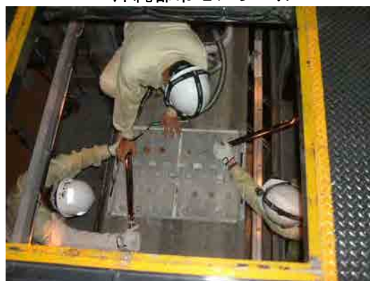
軌道ボルトの点検作業 沖縄都市モノレール
