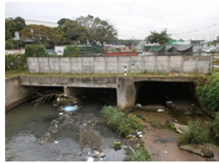
写真2 河川ボックスカルバート
