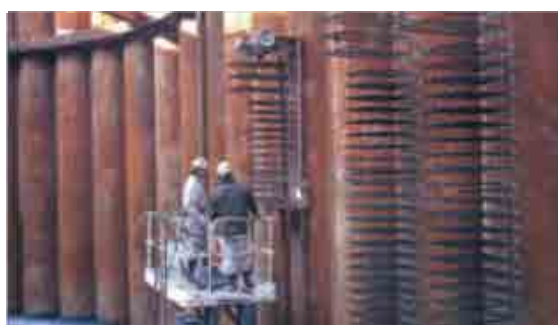
図 20.12 スタッド（頂版結合部）の現場溶接風景
