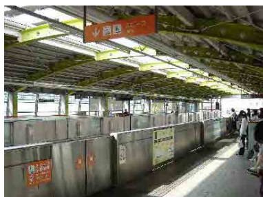
図 7.23 多摩モノレール(日本)のプラットホームスクリーンドア
