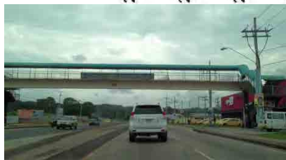
2012年に洪水が発生した区間（路線終点付近）
