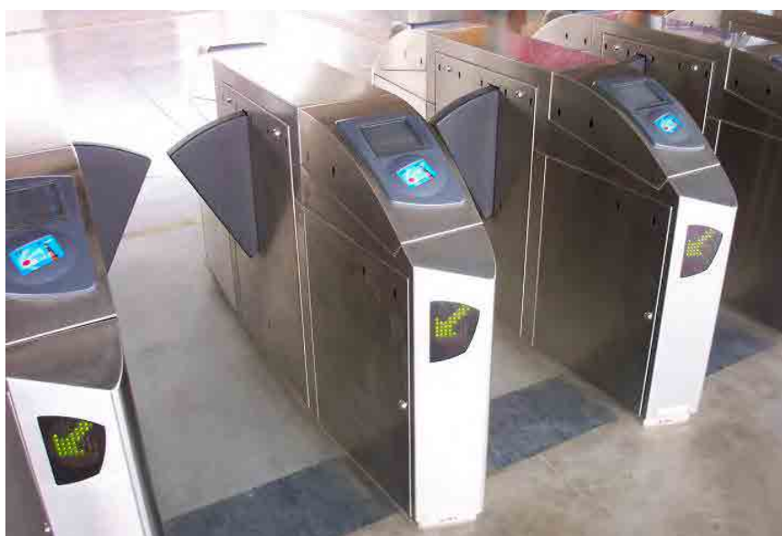
図 7.32 格納式フラップタイプのコントロールゲートの例
