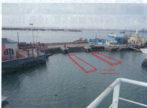
新巡視艇の係留予定地 (ジブチ) (建設中)
