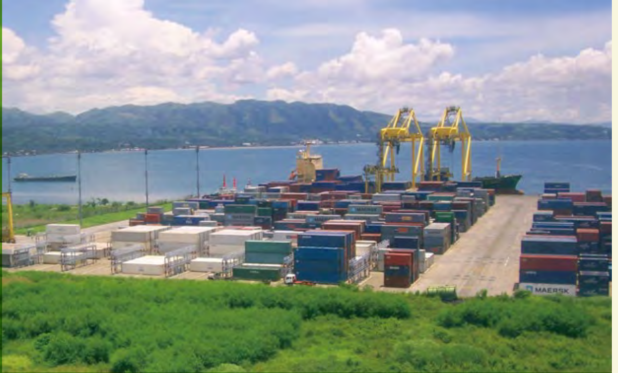
フィリピン：日本の支援により建設されたミンダナオ島のコンテナ埠頭。貨物取扱量が増え、周辺の物流の活発化に寄与している
