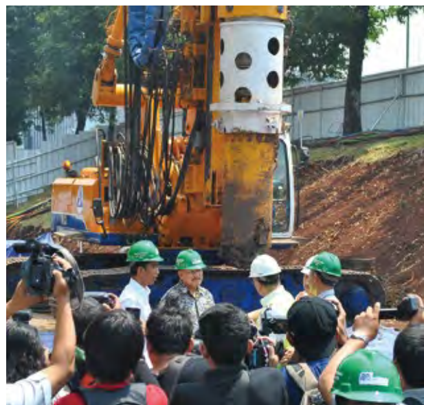
首都の渋滞緩和が期待される「ジャカルタ都市高速鉄道(MRT)南北線」(円借款)の着工式
