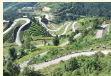
急勾配の山をつづら折りに走るシンズリ道路(第2工区)。ネパールと同様に山の多い日本の技術が生かされています【写真提供：日本工営株式会社】
