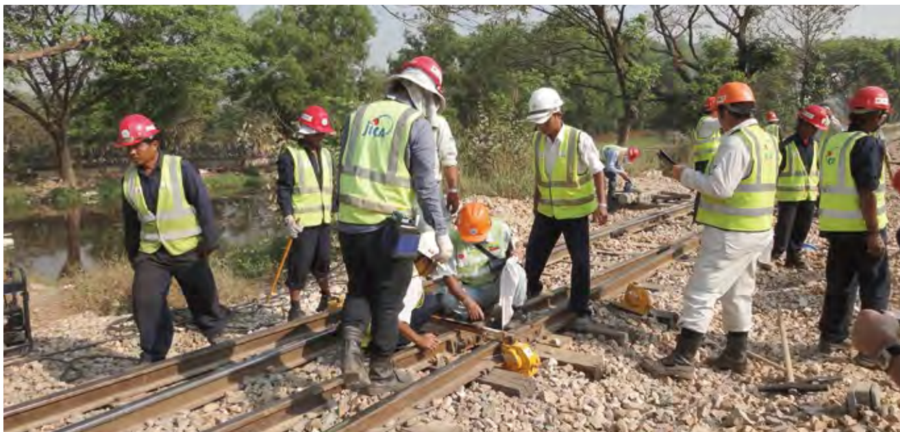
ミャンマー鉄道安全性・サービス向上プロジェクトにて軌道の間隔の測定方法を指導する
