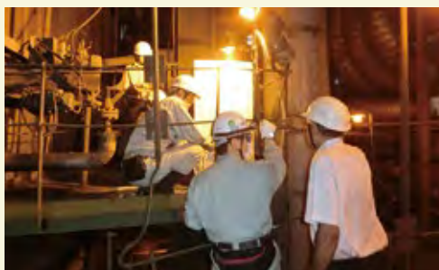
耐熱カメラをボイラー内に設置 【写真提供：株式会社セキュリティージャパン】
