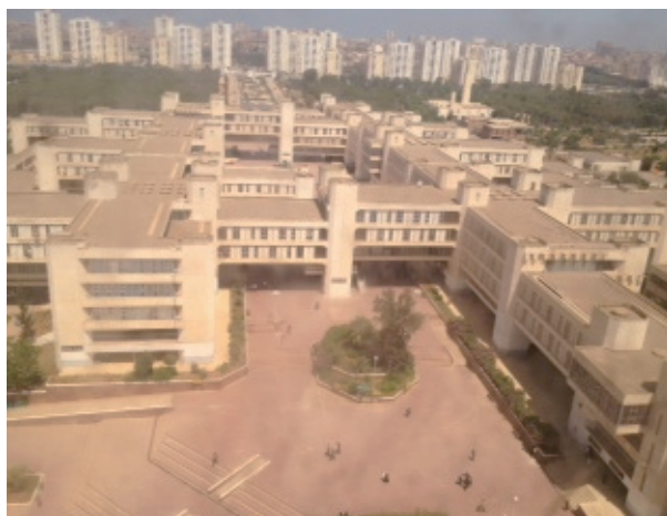
オラン科学技術大学（丹下健三設計、鹿島建設）
