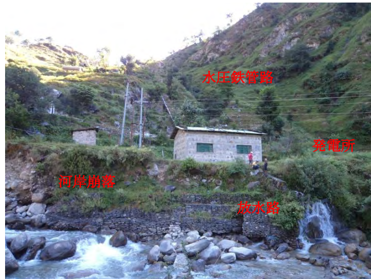
図-7.16 水圧鉄管路、発電所、放水路
