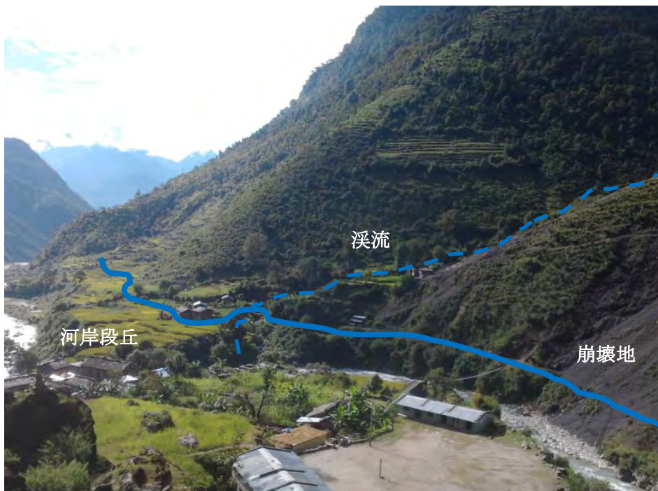
図-7.8 水路中間区間（経過地山側斜面安定）
