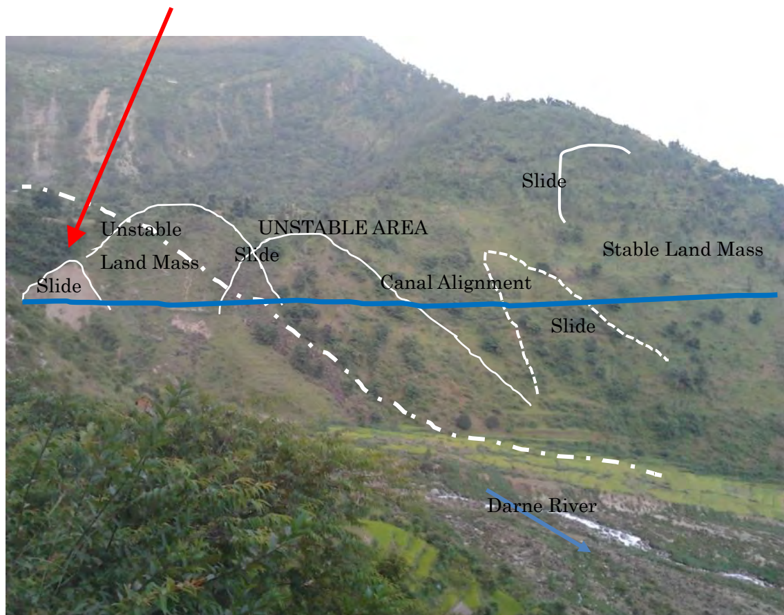
図 - 7.21 水路経過地上流部の崩積土斜面
