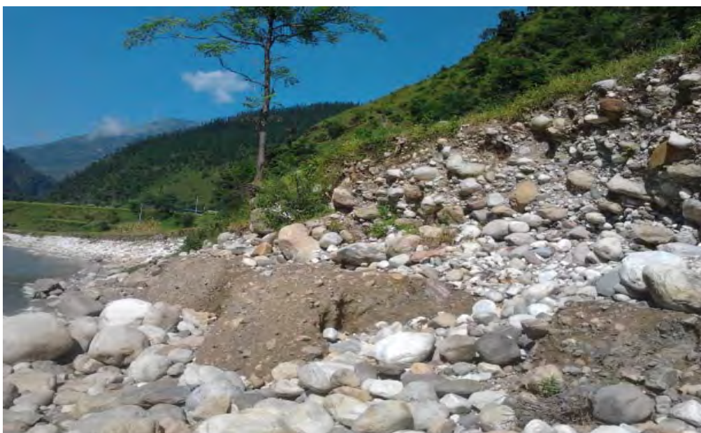
図 - 7.23 放水路出口氾濫原堆積状況
