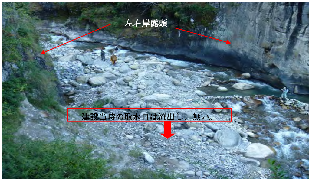
図 - 7.11 バジュラ 取水口地点（下流吊橋より上流望む）
