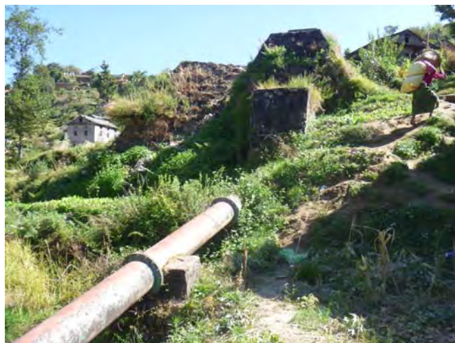
図-7.15 水槽付近斜面安定（住宅地写真左）
