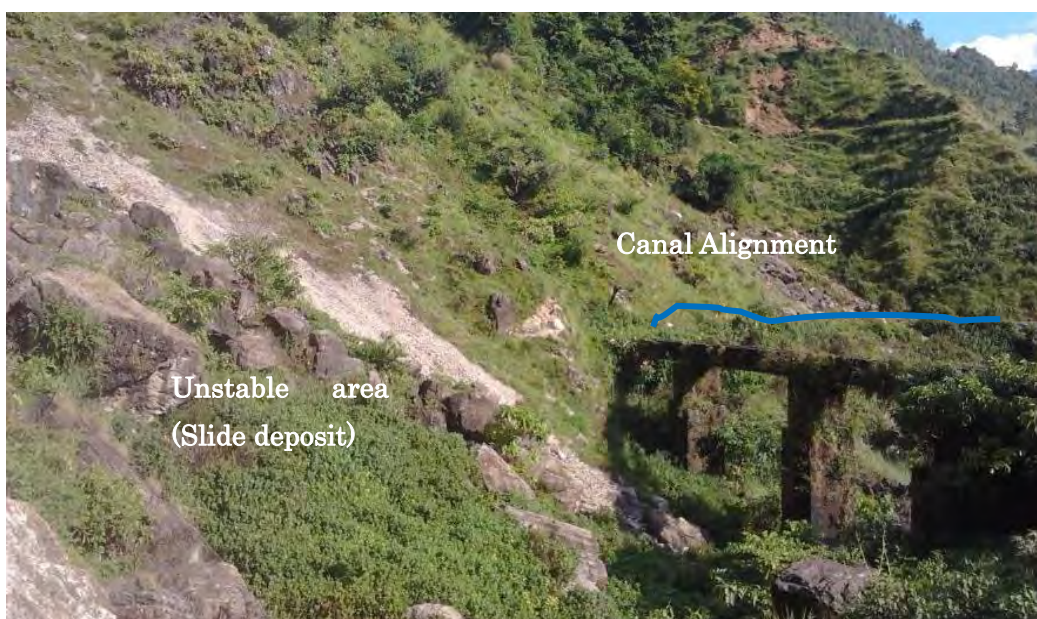
図 - 7.19 シャルプダハ取水口下流左岸、水路橋によって不安定斜面を迂回
