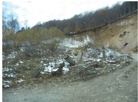
南西部の道路状況（その2）
