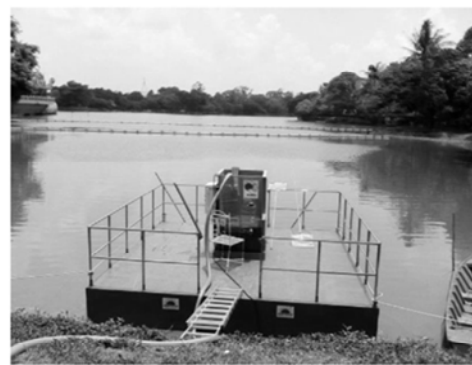
アオコ回収タンクおよび スキマーを設置した筏 (4m×4m)
