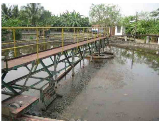
写真 3.5 最終沈澱池
