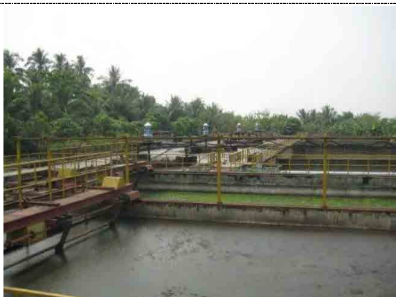
写真 3.5 最終沈澱池
