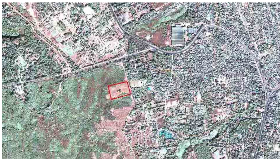
図 E.17 ゾーン 6 の配水池候補地の周辺状況
