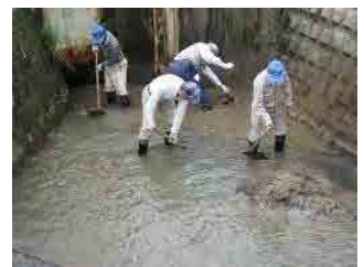
開水路の清掃
