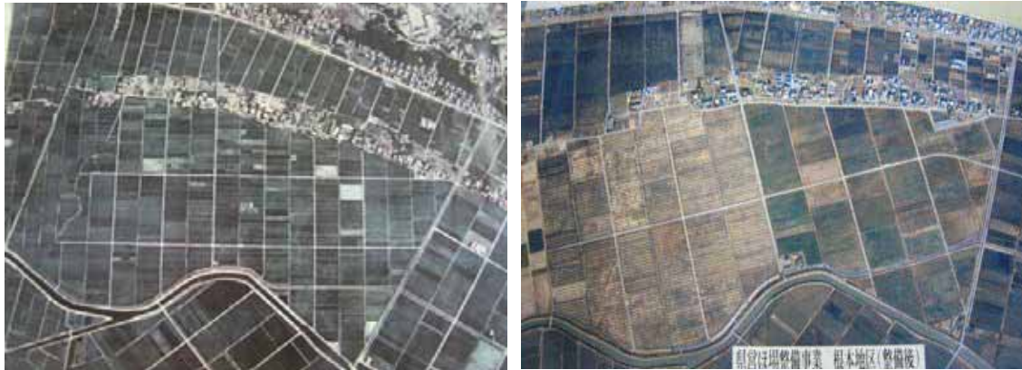
ပုံ(၂.၂.၃)(၀.၂)ဟက်တာမှ (၁)ဟက်တာထက်အကျယ်လယ်ကွက်များဖော်ဆောင်ခြင်း နီမိုတိုဒေသအဆင့်မြင့်လယ်ယာဖော်ဆောင်ရေးစီမံကိန်း၊ အိဘာရာကီ၊ ဂျပန်
