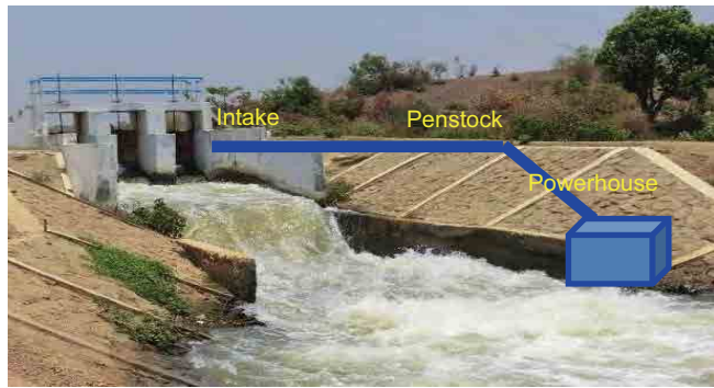
図 2.6.8 R.D21+952 の分水工地点での発電設備の概略配置 出典：JICA 調査団
