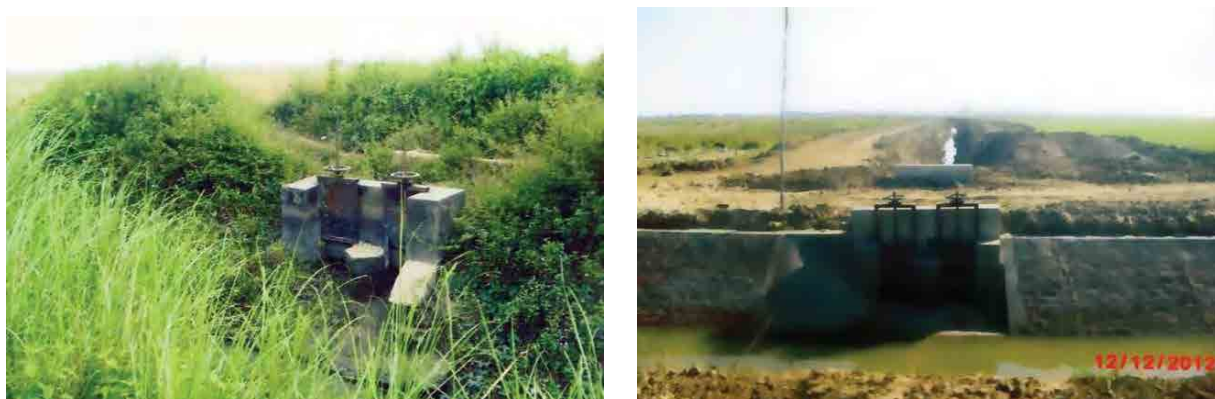
図 3.1.2 改修獅子改修実施前（左）と改修実施後（右）の状況
