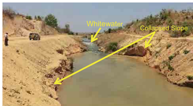
R.D 18+900 地点の上流部の急流部
