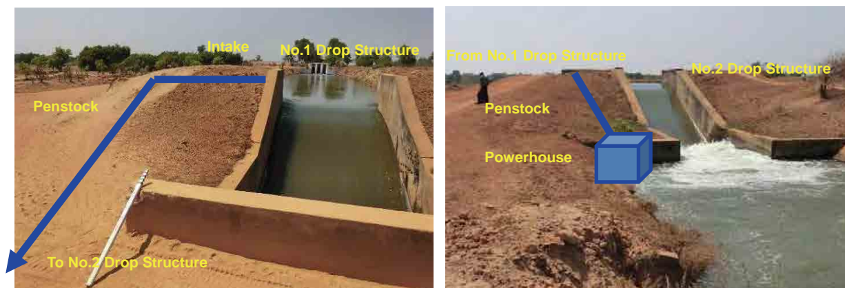
図 2.6.7 Wegyi Left Main Canalの第一、第二落差工を利用した小水力発電所の概略配置
