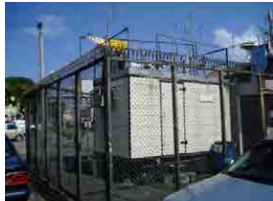
大気汚染モニタリングステーション コロンボフォート駅前の道路沿いにあるコロンボ市内で唯一のモニタリングステーション。現在はPM10のみモニタリング。
