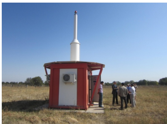
写真-5：航行中の航空機に対して方位と距離情報を提供する VOR/DME 施設。滑走路 26 側末端から 1.5 km の位置に 1995 年に設置され、進入・出発方式用、航空路用として利用されている。
