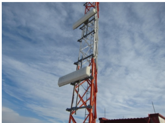
写真-4：滑走路 26 側進入用のグライドパス (GP)。形式、カテゴリ、設置年は 08 側と同じ。ILS 進入コースの垂直方向の電波を発信している。
