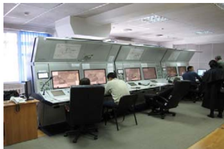
写真 2-1.9 航空路およびレーダー管制卓
