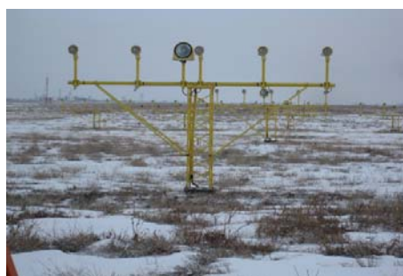
写真 2-1.11 標準式進入灯および連鎖式閃光灯 写真 2-1.12 滑走路 26 側進入用標準式進入灯
