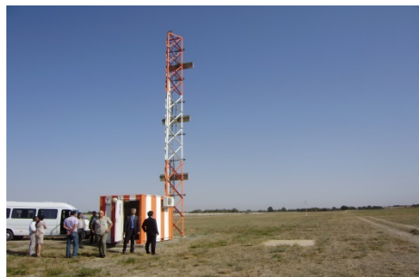
写真 2-1.6 既設 GP 空中線装置およびシェルタ
