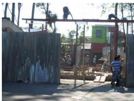
救急車駐車場建設地
