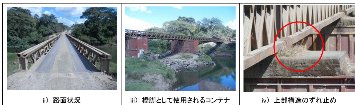
写真 3-2.10 供用中の仮設橋
