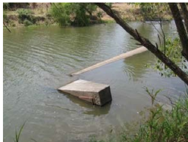
河川内に残存する橋脚の一部
