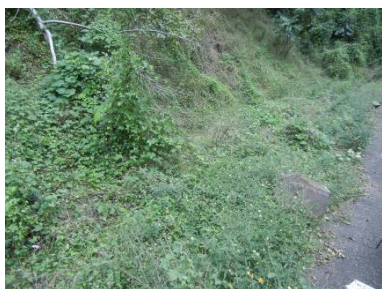
縦断排水施設 土側溝 W2.5m×h0.5m
