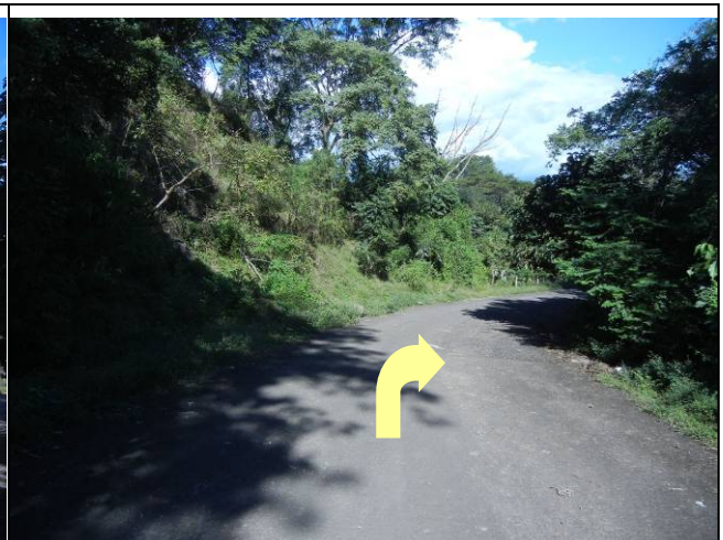
写真-14：右岸側取付道路（急カーブ）
