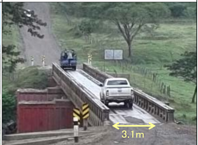
写真-10：仮設橋の使用状況
