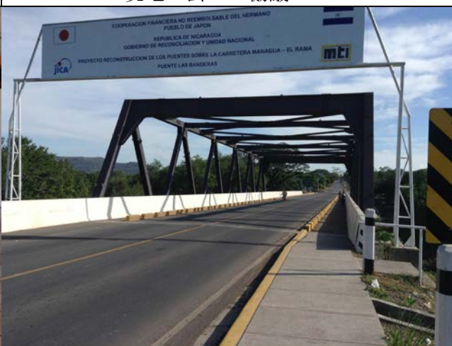
写真-4： 供用を開始したラス・バンデラス橋 (本邦無償資金協力)
