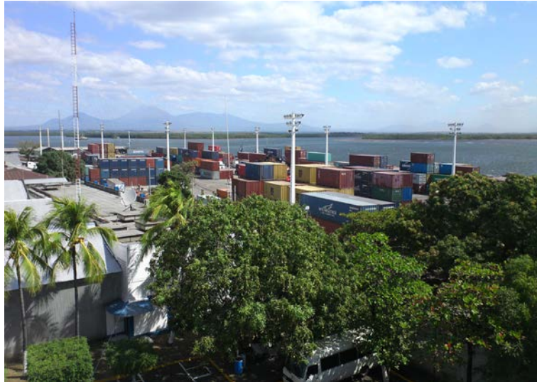
写真 3-2.11 コリント港全景
