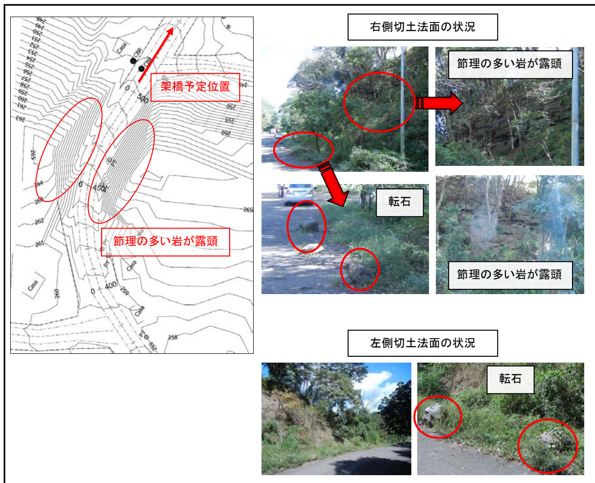
図 3-2.3 切土部の状況
