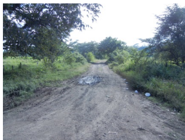
終点付近の幅 5.6m 碎石道路
