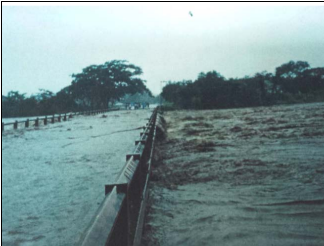
写真-7：1998年の旧パソ・レアル橋流出時の状況
