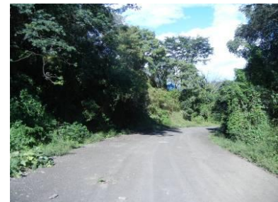
取付道路 始点付近
