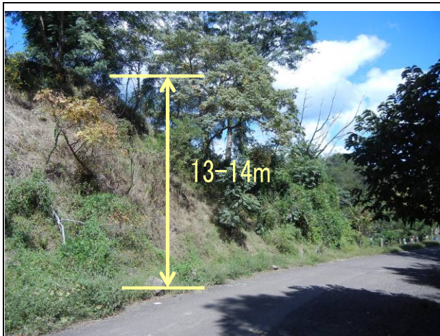
写真-13：右岸側取付道路（崖 H=13-14m）
