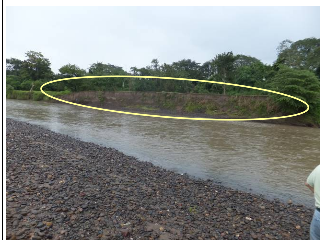
写真-15：上流水衝部の河岸洗掘
