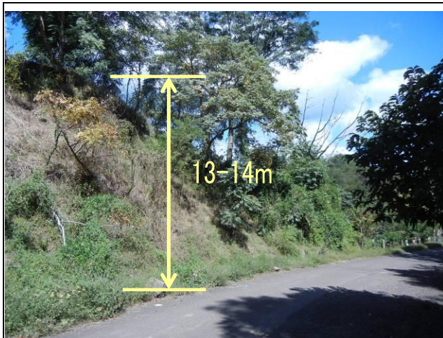
写真-13：右岸側取付道路（崖 H=13-14m）
