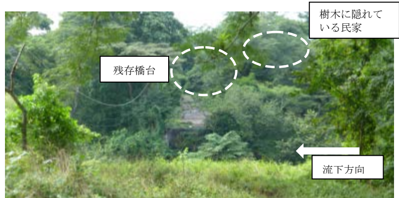
写真 3-2.6 旧パソレアル橋の残存橋台付近（2013 年 11 月）
