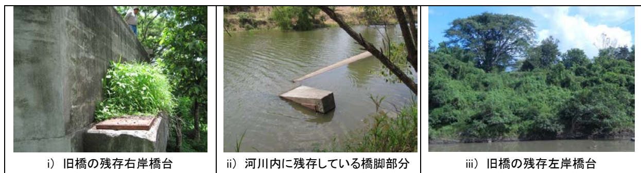
写真 3-2.9 旧パソ・レアル橋の残存状況
