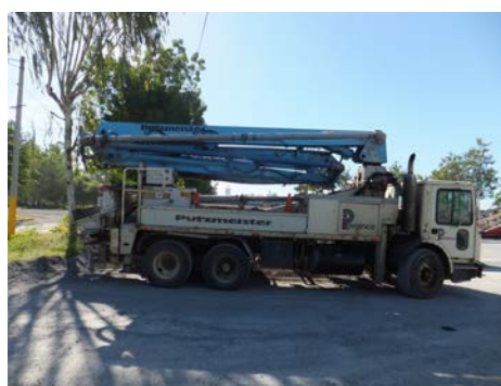
コンクリートポンプ車
