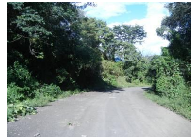
取付道路 始点付近
