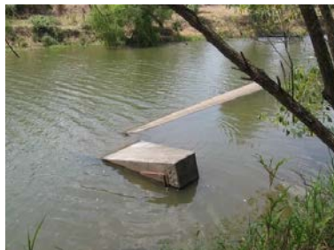
河川内に残存する橋脚の一部
