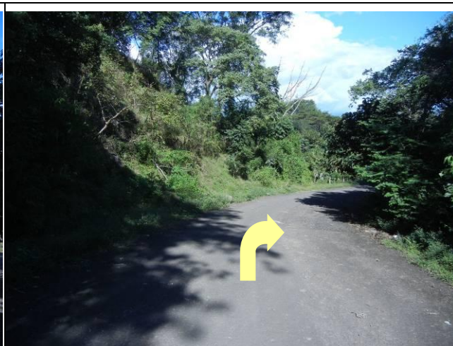
写真-14：右岸側取付道路（急カーブ）
