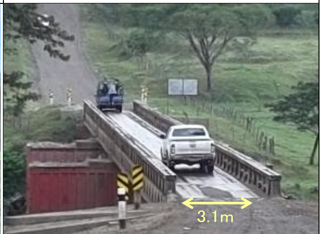
写真-10：仮設橋の使用状況
