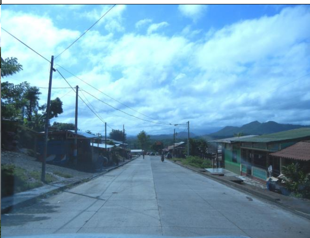
写真-6： パソ・レアル橋が位置する 21B 号線 (マティグアスーリオ・ブランコ間) コンクリート舗装による整備済み区間
