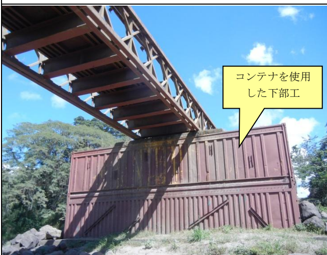
写真-11：コンテナを使用した仮設橋下部工
