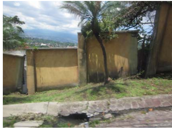
【コスタリカ】地すべりによる変状 パイロットサイト候補のエスカス市にて。
