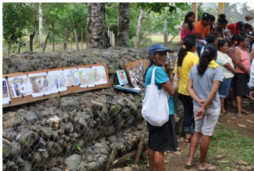
【パナマ】BOSAI フェーズ1の好事例 住民参加で実施する蛇かごによる堤防作りは現在も住民が維持管理している。
