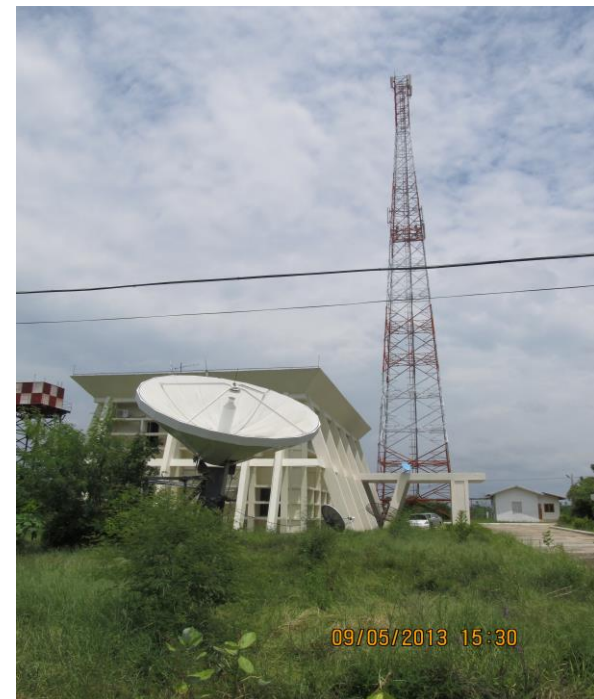
Taungtwingyi 交換局 (中小 10 都市の調査より) インターネット用 IP STAR 衛星地上局が設備されてお り、交換局との間は直埋設光ケーブル(12 芯)にて接続、 加入者は 5 加入のみ
