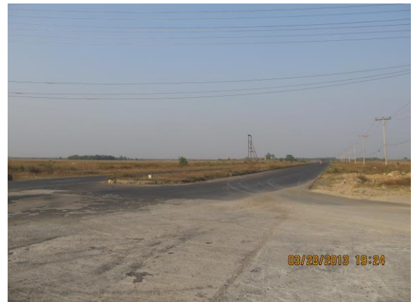
ティラワ工業団地(SEZ)用地, (敷地面積: 約 2,400ha) クラス A 内敷地面積中間を走る道路の左側が 400ha で 第一期整備となる。本計画では SEZ 境界まで光ファイバー による通信回線を準備する。
