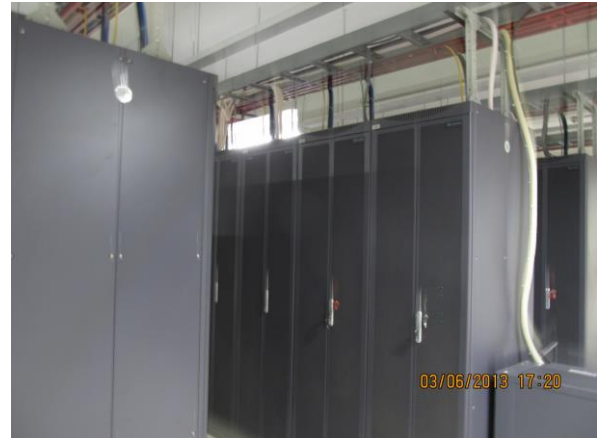
Dekkhina 交換局、新局舎に中国製交換機器を建設中。
