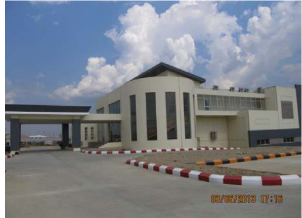
ネピドー市内に新築のDekkhina交換局、本計画では、NOC (Network Operation Center)が設置される予定になっている。
