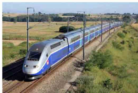
Công trình đào đắp, TGV Sub-Est
