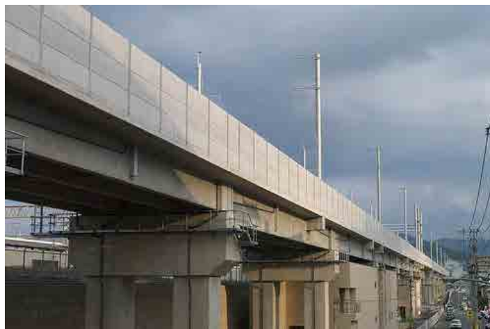
Hình 2.1.2 4 dầm chính T-PC đơn giản (L=35m)
