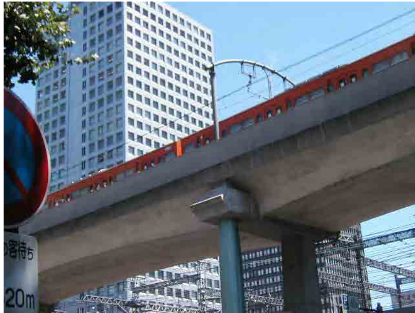
Hình 2.2.1 Cầu bê tông gắn lan can cách âm có tính tới yếu tố mỹ quan
