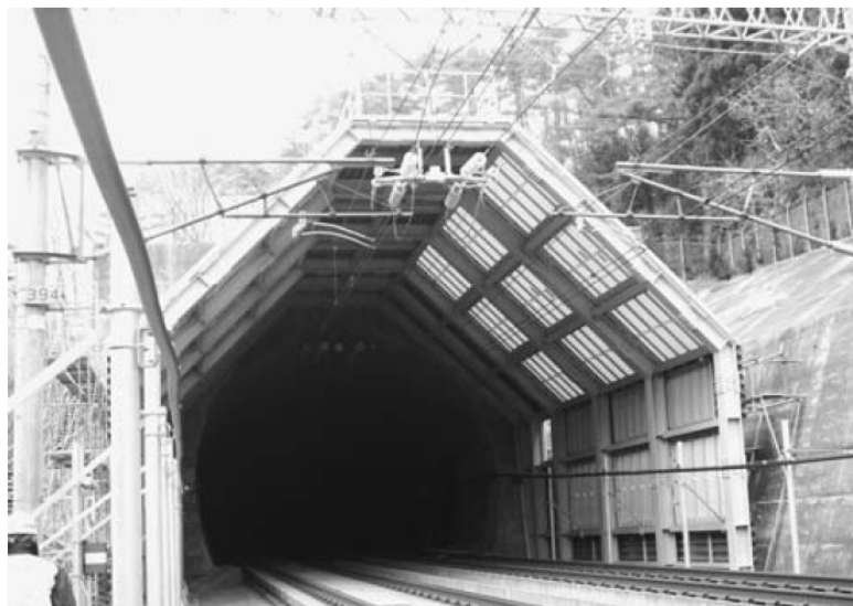
Hình 2.2.2 Giải pháp hầm đệm đối với sóng vi áp trong hầm
