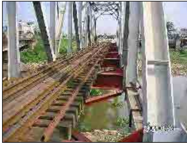
Hình 5.3.25 Tà vẹt cầu trên đoạn Hà Nội - Ninh Bình
