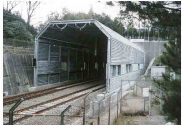
Hình 5B.3 Hai ví dụ điển hình hầm đệm cho tàu Shinkansen
