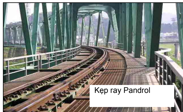
Hình 5.3.26 Nền bất trực tiếp trên dầm thép - cầu Kubo tỉnh Saga, Nhật Bản
