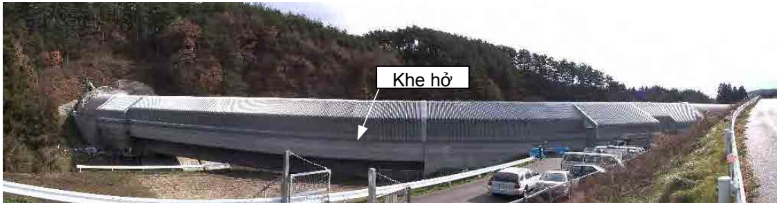
Hình 5B.4 Mái che có khe hở lắp đặt cho Shinkansen
