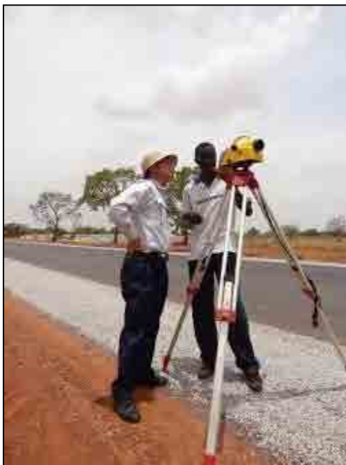
Photo 4-3 Encadrement sur l'opération du nivellement
