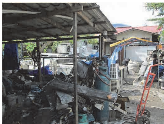
解体業者のヤード風景
