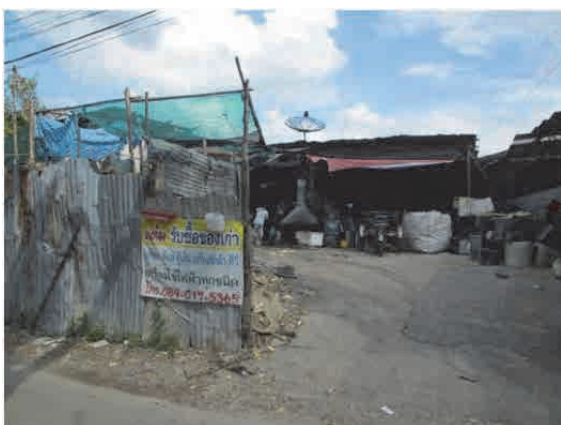
解体業者の外観
