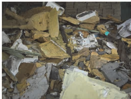
投棄される断熱材フロン
