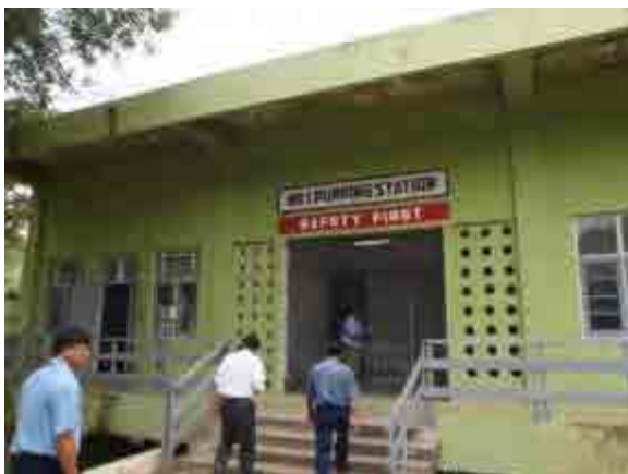
ポンプ場 No.1 イラワジ河から取水後、No2 へ送水する。
