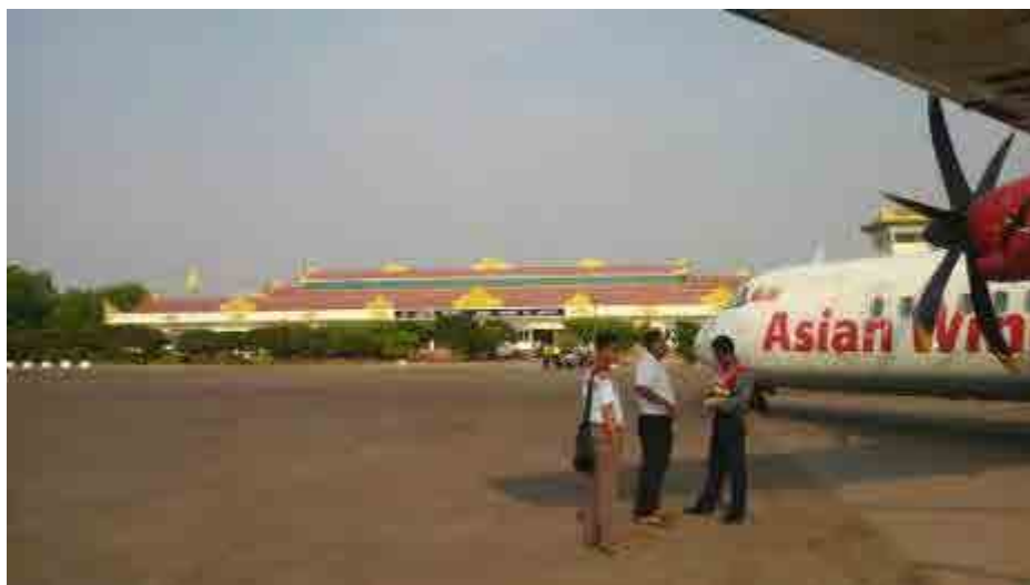
観光地であるバガンの観光地の空港ということもあって、王宮の屋根のイメージをターミナルビルにも取り入れている。ボーディングブリッジはない。
