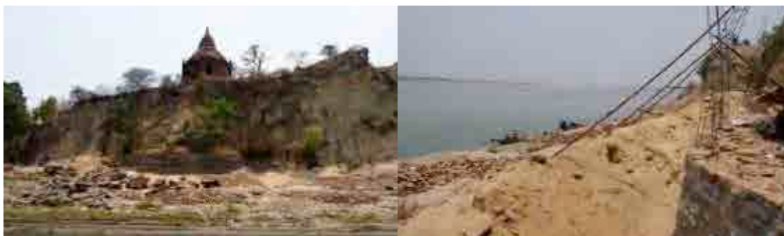
イラワジ河護岸工事 1
