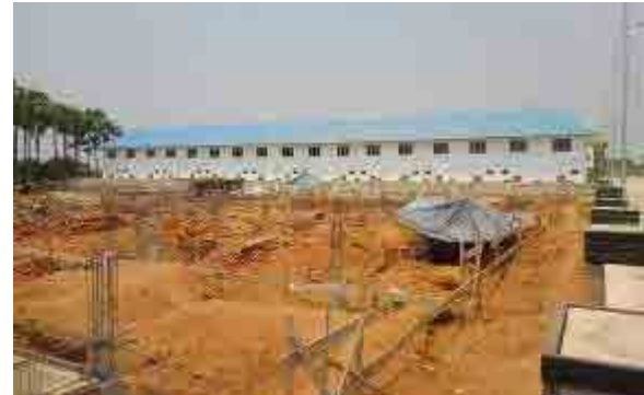
バスターミナルの手前に建設中のホテル。 このホテルの建設許可を得るために、 バスターミナルの整備を引き受けることになった。
