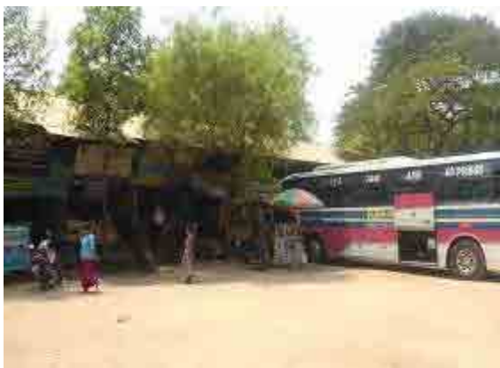
ニャンウータウンにある既存のバスターミナル。 駐車スペースは狭く、舗装されていない。
