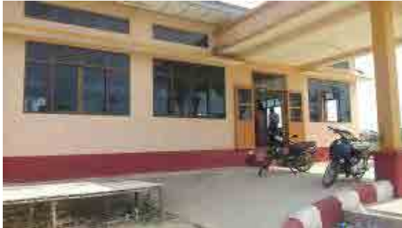
ニャンウータウン変電所(2)2013年に建設
