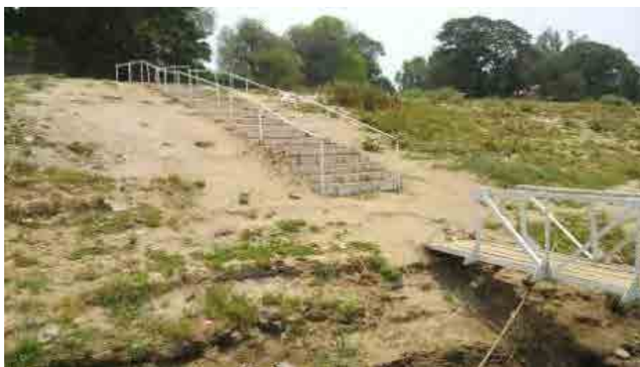
簡易的な階段と棧橋。雨期には、この階段のほとんどが水没するので、毎年作り直す。
