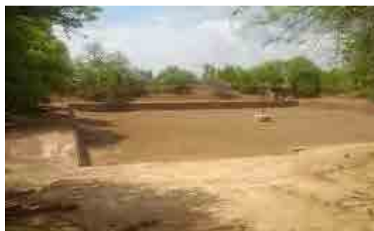
13世紀に建造されたMin-nan-thu村の貯水池 (37mX37 mX4mH)。乾期は干上がっており、 現在では雨期だけ活用されている。
