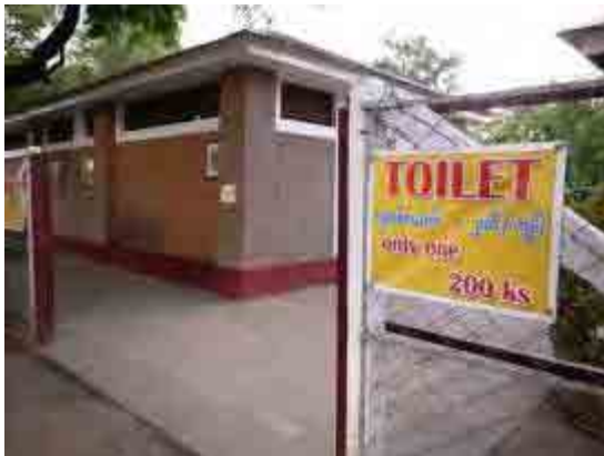
公衆トイレ全景
