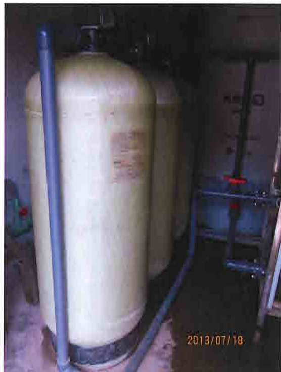
水酸化第一鉄吸着タンク
