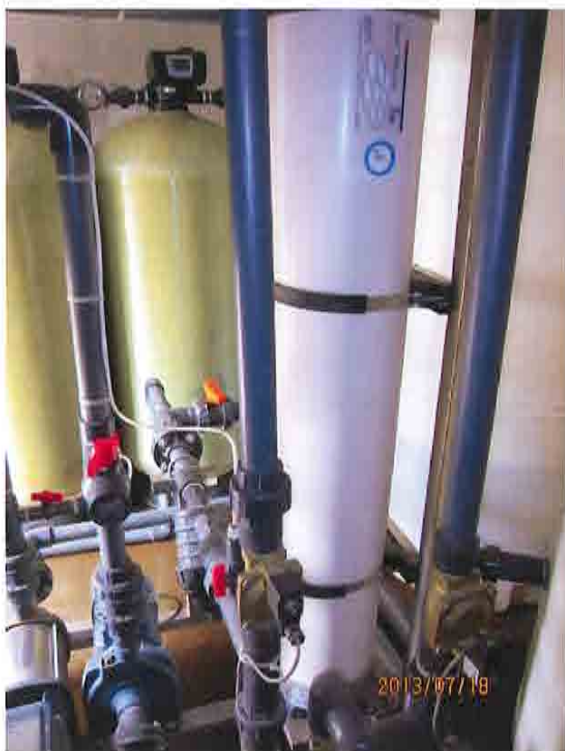
限外濾過タンク(1)
