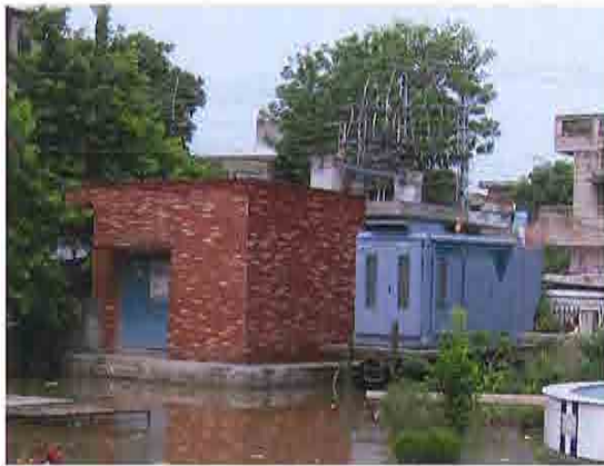
ヒ素除去施設全景（既存深井戸に隣接）
