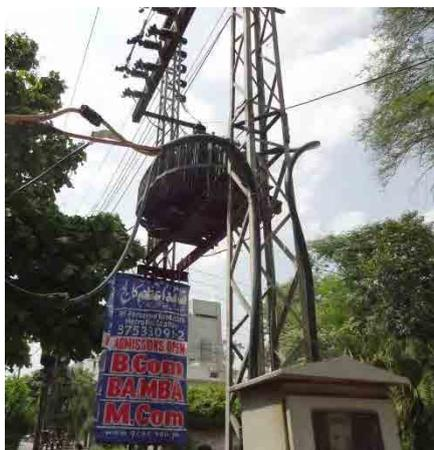
写真 2-11 受電用変圧器 (200 kVA)
