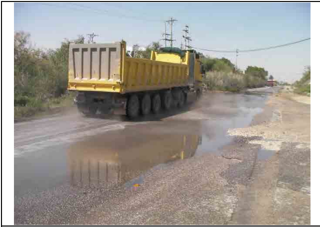
キングフセイン橋アクセス路の悪路区間
