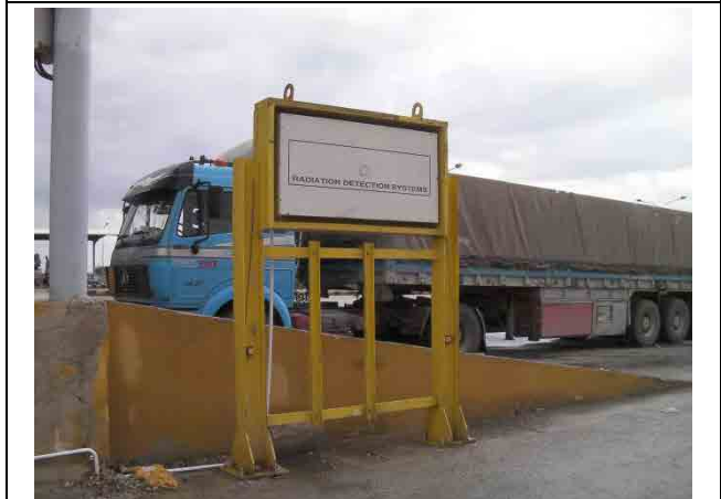
故障中の検査装置
