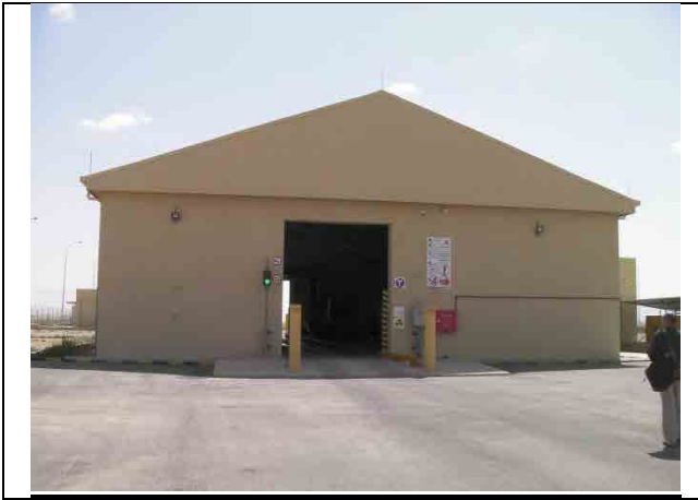
大型 X 線検査(スキャナー)棟外観
