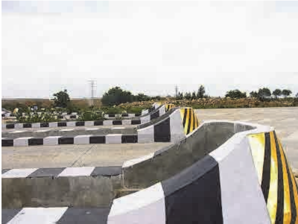
ETC 設置予定現場
