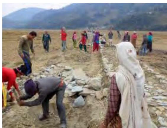
Kaski 郡 Chapakot, Ward 1, 2 の住民が 共同で歩道整備をしている様子
