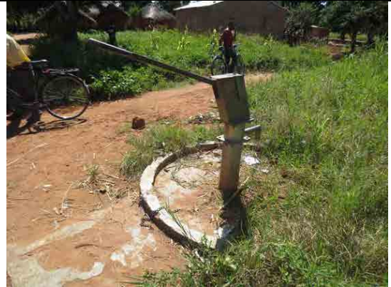
写真-6 廃棄された深井戸 井戸の施工が悪く、枯渇したため廃棄となった施設。揚水試験、電気検層結果の解析に基づくスクリーンの設置などの適切な施工管理が求められる。 (ムウェンセ郡)
