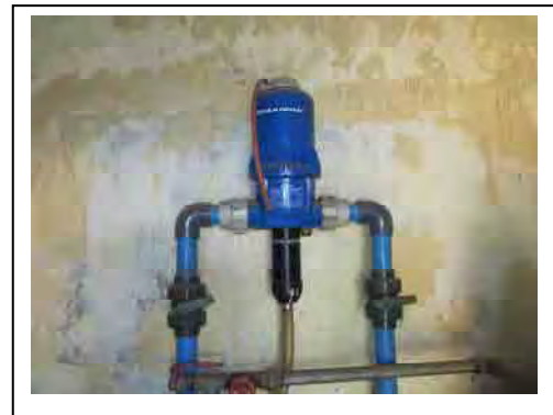
【水道水圧駆動型の添加器】
