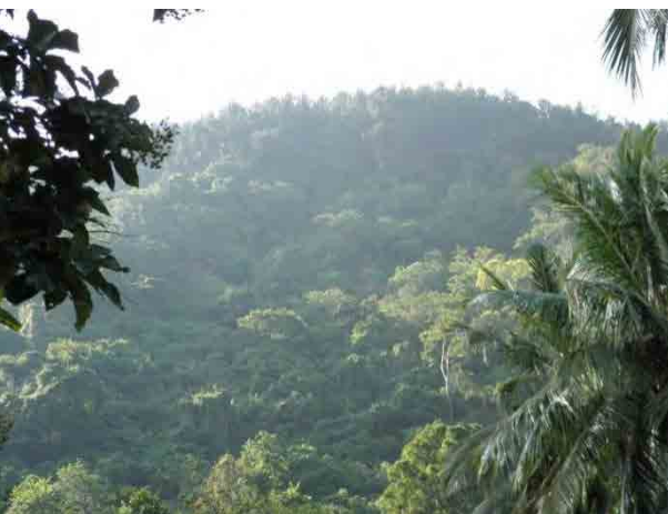
アラグマレ落石危険斜面全景 (パイロット事業実施予定箇所)
