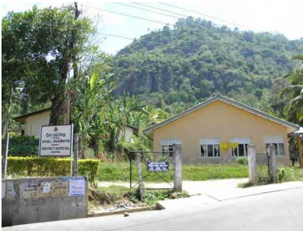
ディンブрана病院周辺の地すべり全景 (実施しない箇所)
