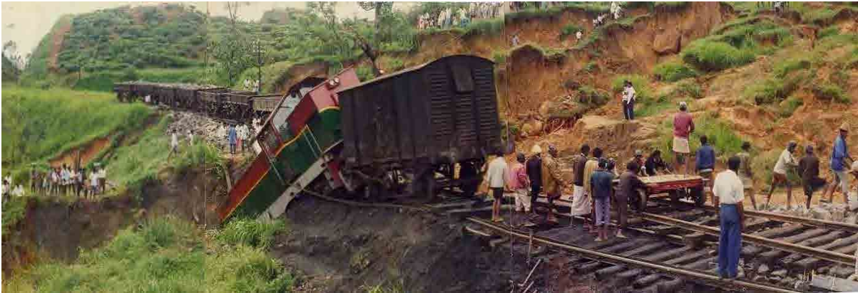
図 3-1-2 ワタワラ地すべりと列車被害 (NBRO)
