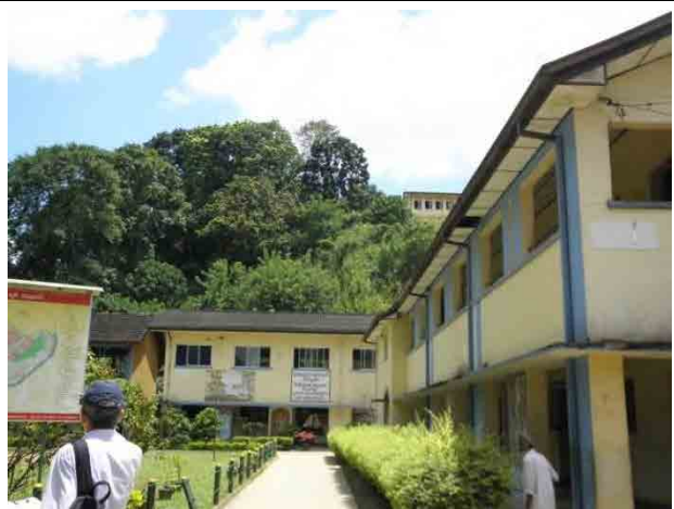
ワッテガマ中央学校裏の斜面崩壊危険斜面 (実施しない箇所)
