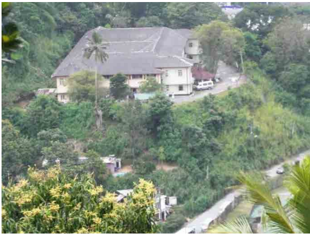
Nurse's Training College 斜面全景 (パイロット事業実施予定箇所)
