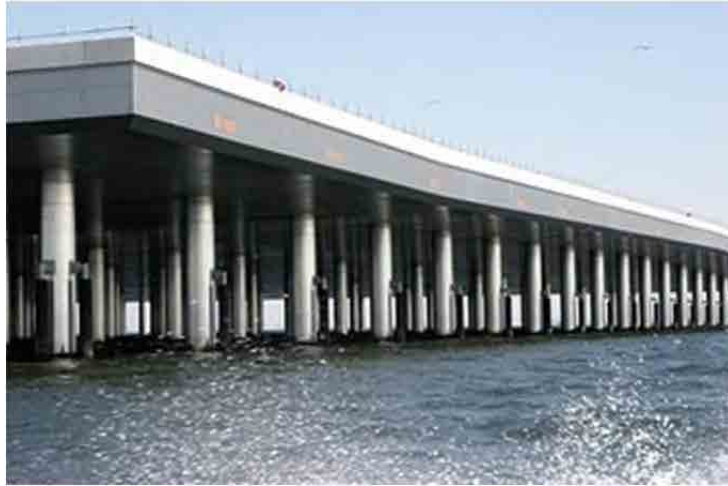
Figura C.31 Pista de aterrizaje y despegue sostenida por un conjunto de pilotes
