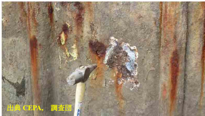
図 8.15 A 岸壁の鋼矢板セルの表面の劣化状況
