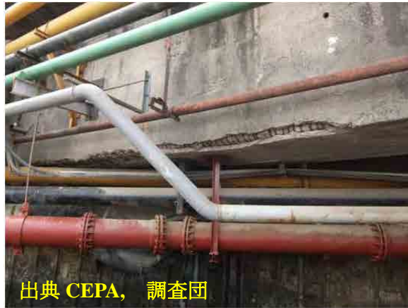
図 8.13 A 岸壁の上部工の剥落状況
