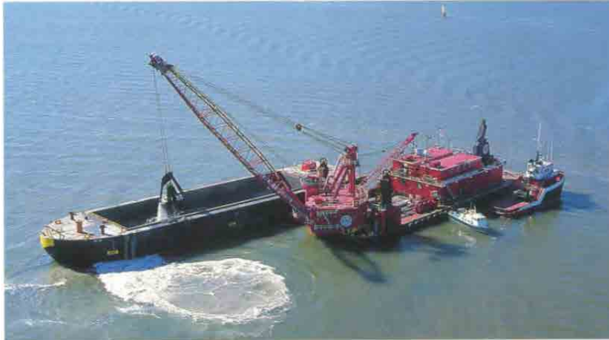
写真 5.4 グラブ浚渫船 (台船形状)
