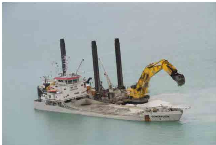
写真 5.5 バックホー浚渫船
