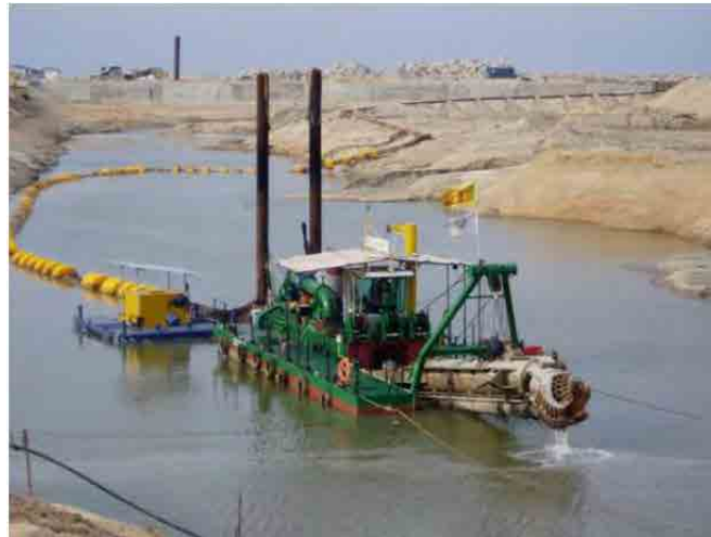
写真 5.1 カッターサクシオン浚渫船
