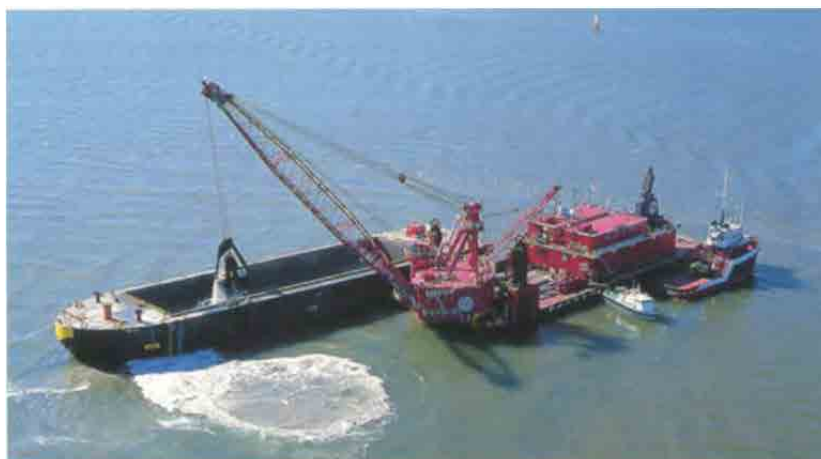
写真 5.4 グラブ浚渫船 (台船形状)
