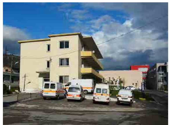
6. エルバサン地域病院 救急病棟及び検査室
