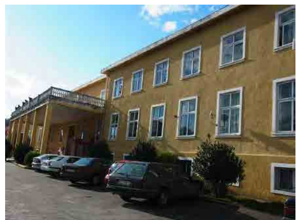
4. エルバサン地域病院 本館 内科棟
