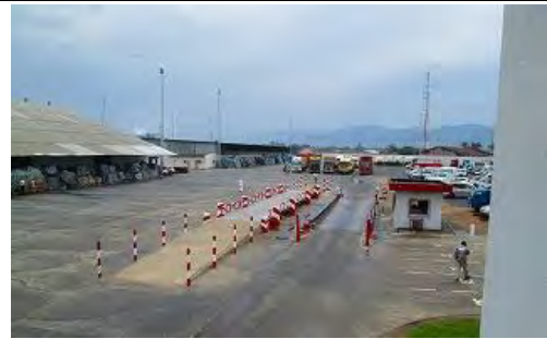
写真-12 トラックスケール全容 全ての貨物車と国境通過車両の重量を計測
