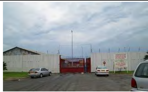
写真-28 港湾出口ゲート現況 貨物車両以外の車両はいつでも通行可能
