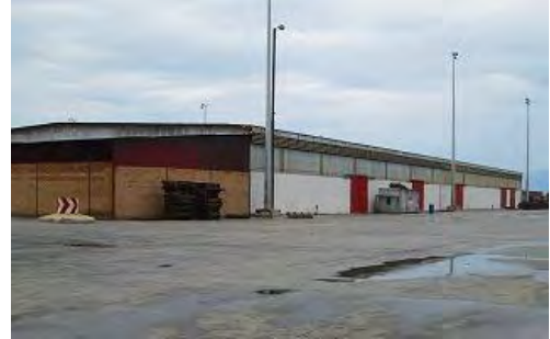
写真-20 第4倉庫外観(岸壁側)
