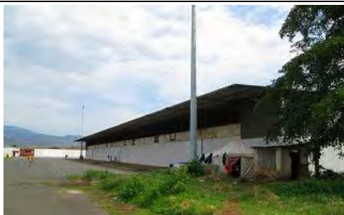
写真-13 第1倉庫外観 輸出用コーヒー豆が取り扱われている
