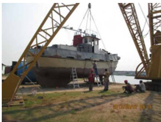
写真 2-1 既設クレーンにて タグボート上架
