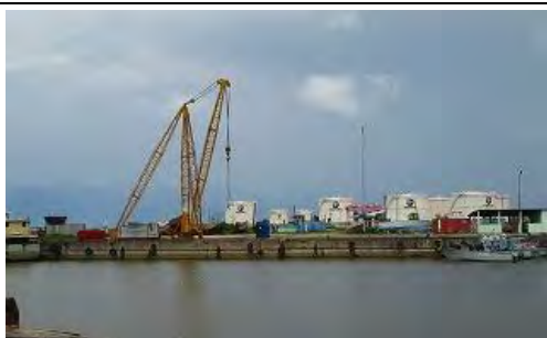
写真-7 既存「コンテナバース」現況 油槽所の石油タンクが見える
