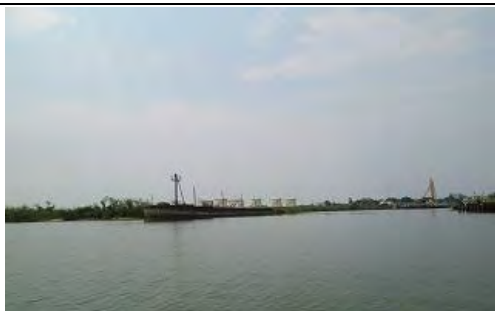
写真-1 ブジュンブラ港港口現況 左手は北側防波堤、右手は軍棧橋の端
