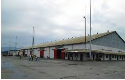
写真-17 第3倉庫外観
