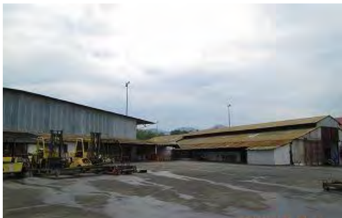
写真-23 ブジュンブラ港の修理工場
