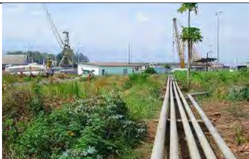
写真-29 建設サイトを横切る パイプライン現況 移設排水路はこの下を横切る
