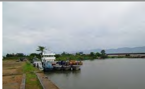
写真-8 既存「コンテナバース」現況 観光・調査船などの小型船が係留している
