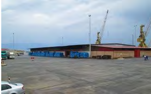
写真-19 第4倉庫外観 (パーキングエリア側)
